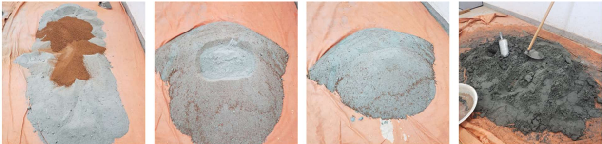
Figura 25 - Processo de mistura do adobe
