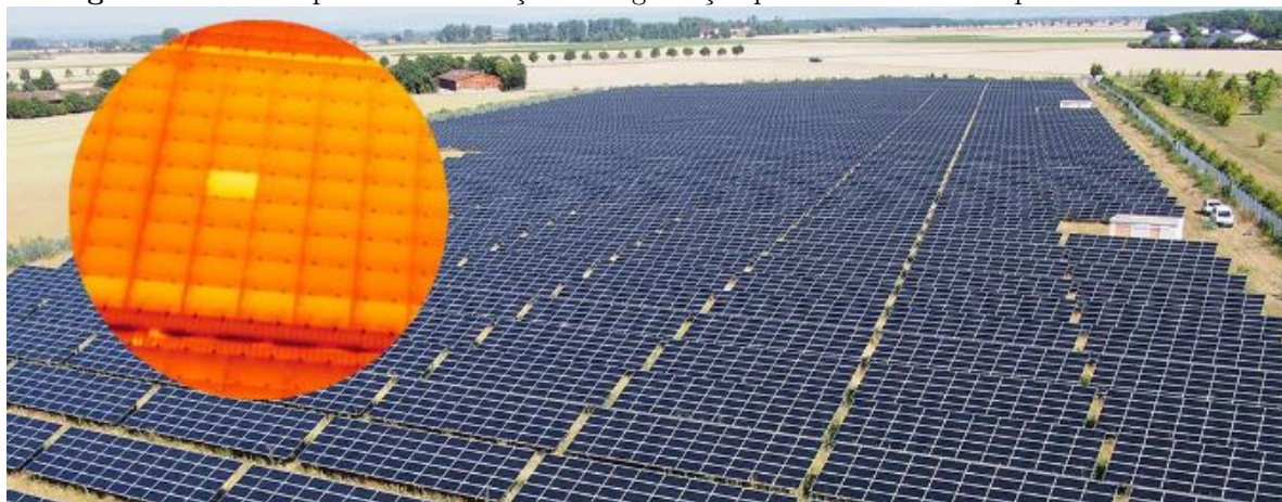
Figura 5.10. Exemplo de identificação de degradação pela análise com IR por meio de drone .
