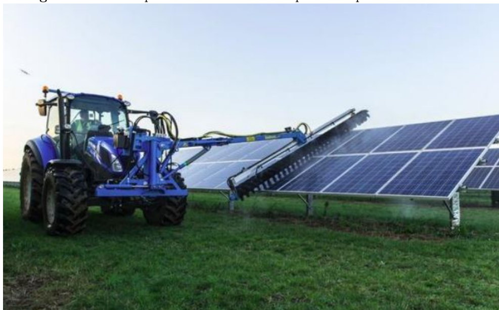
Figura 5.11. Exemplo de tratores utilizados para a limpeza dos módulos FV.
