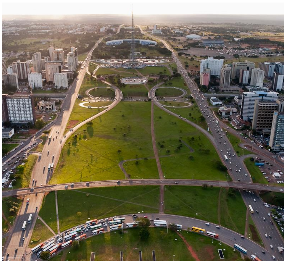
Figura 110. Canteiro central do Eixo Monumental – Torre de TV. Fonte: Joana França.
