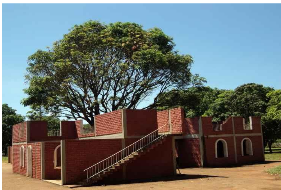
Figura 196. Castelinho – antes da intervenção. Fonte: shorturl.at/anT23 .
