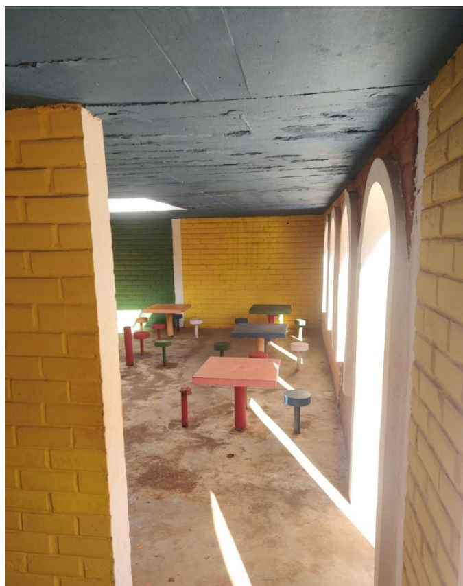
Figura 199. Castelinho – interior com mesas e bancos de concreto (2023). Fonte: Arquivo pessoal.
