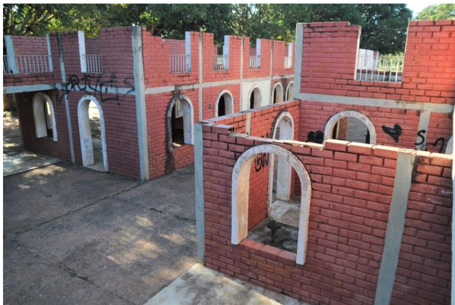
Figura 195. Castelinho – antes da intervenção. Fonte: shorturl.at/aJO24 .
