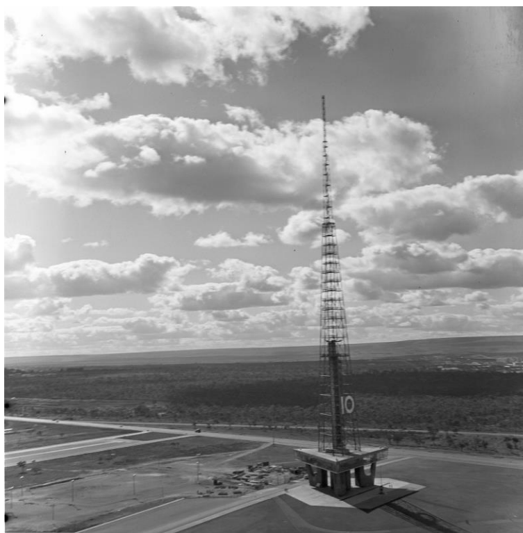
Figura 120. Torre de TV – vista para onde deveria ter sido implantada a hípica e o Jardim Zoológico. Fonte: Arquivo Público do Distrito Federal.
