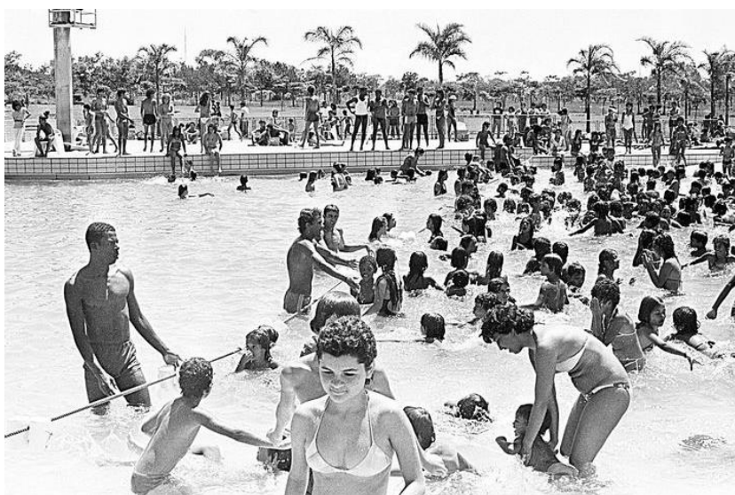
Figura 247. Piscina com Ondas no dia da inauguração do Parque da Cidade (1978). Fonte: Arquivo Público
