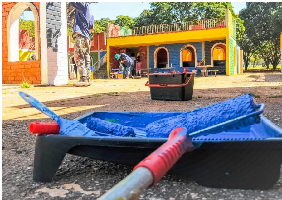
Figura 197. Castelinho – durante a intervenção (2021). Fonte: shorturl.at/iLPZ5 .
