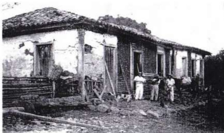
Figura 3: Edificação antiga da Fazenda da Papuda em 1959
