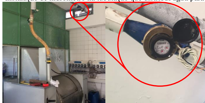
Figura 11 – Instalação de hidrômetro na tubulação que distribui água para a lavanderia
