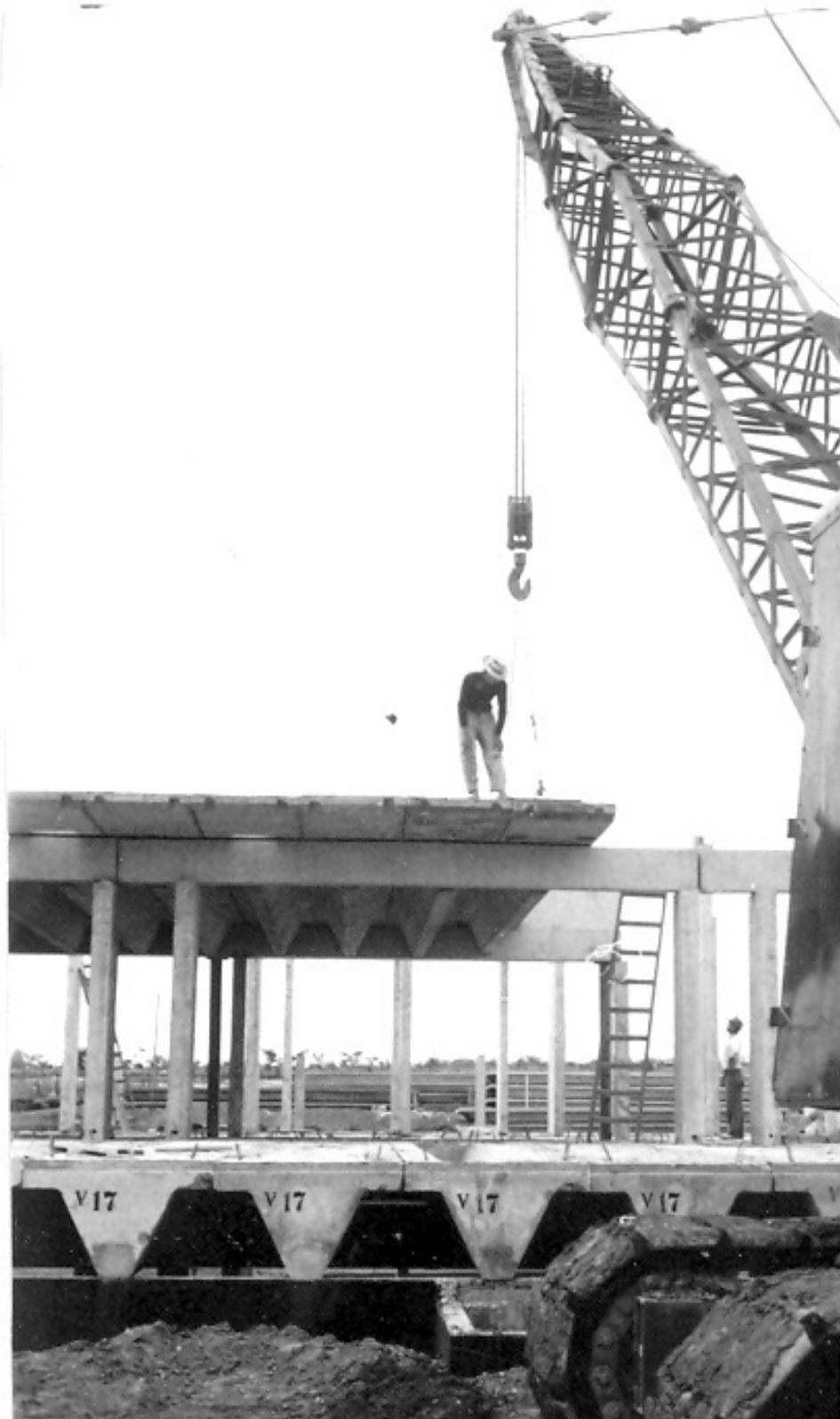
Figura 19 - Vista do pavimento térreo. Montagem das vigas que formam o piso da sobreloja.
