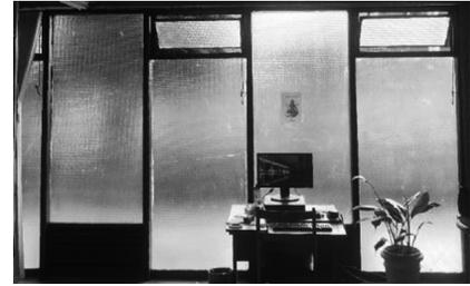
**Figura 6.** Imagem de sala administrativa do bloco A, voltada para a rua central, onde se percebe o fechamento com vidros aramados (translúcidos).
