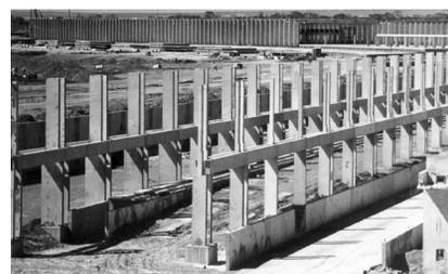
Figura 13 - Construção de radier. ICC. Fonte: Arquivo UnB
