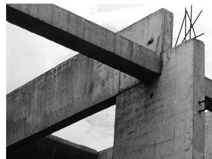
Figura 19 - Encaixe entre vigas e pilar. Barra prolongada no topo da coluna.
