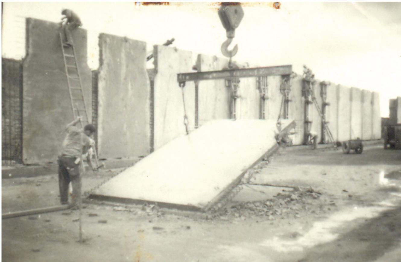
**Figura 16** – Vista do subsolo. Montagem de placas pré-moldadas para contenção do solo.
