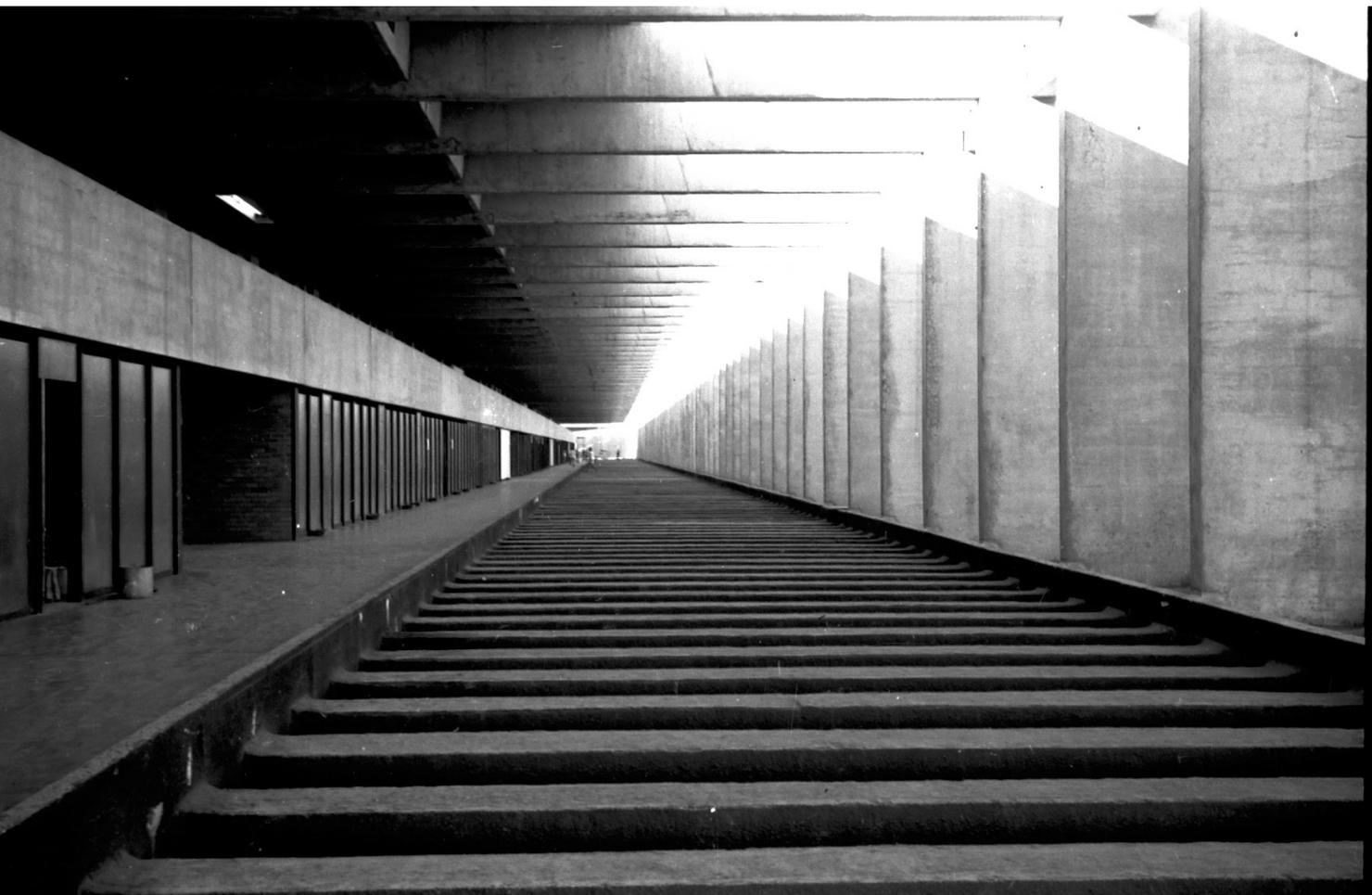
Figura 22 - Vista do Bloco A. Em primeiro plano, a estrutura para execução do jardim.
