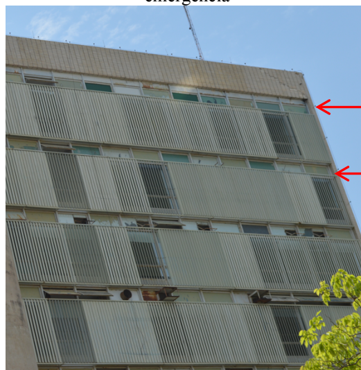
(d) Encontro com a fachada norte
