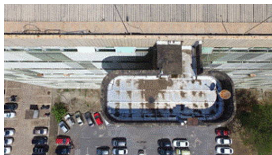
(b) Encontro da fachada com a escada de emergência
