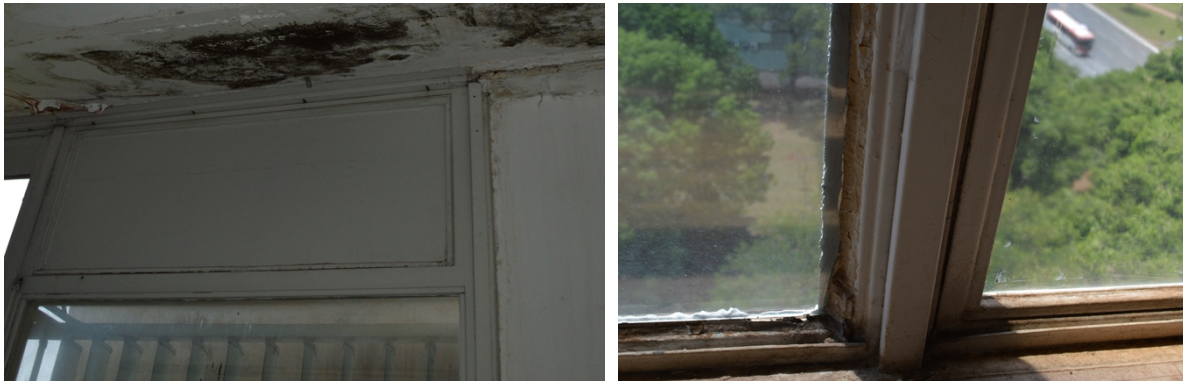
(a) Baguete fixado no contorno da folha
