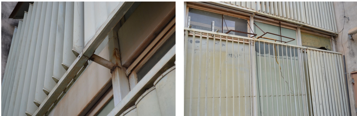
(a) Fixação dos brises metálicos
