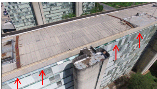
(a) Encontro da fachada com a platibanda
