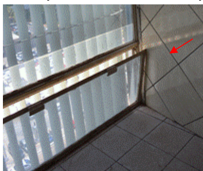
(a) Funcionamento precário da folha de tombar
