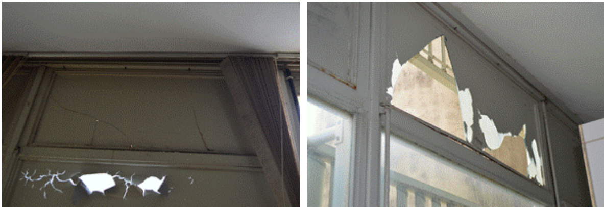
(a) Vidro trincado encaixilhado
