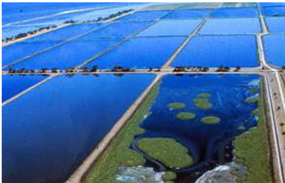
Figura 22: Lagoas de tratamento de esgoto
