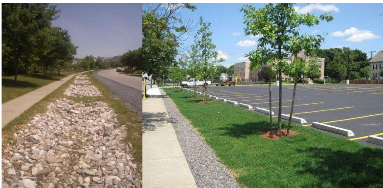
Figuras 44a e 44b: Trincheira de infiltração
