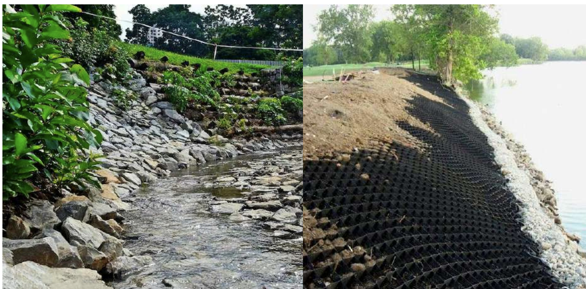
Figuras 43a e 43b: Técnicas de bioengenharia.
