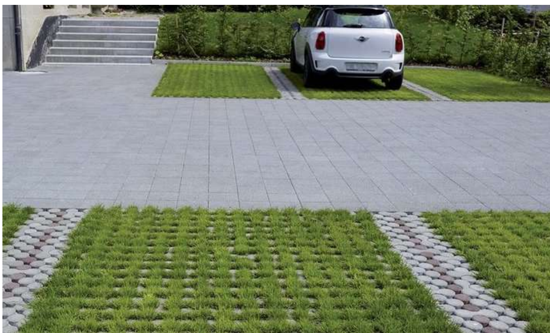
Figura 53: Estacionamento em pavimento permeável.
