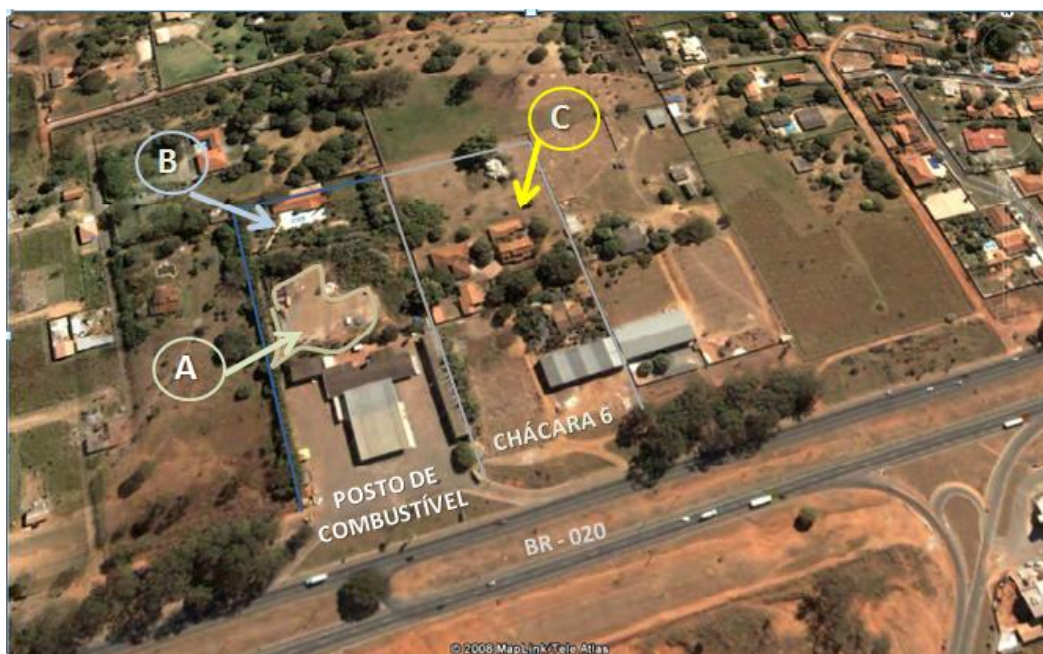
Figura 18. Vista aérea da região do Posto Revendedor de Combustível: A- área dos fundos do posto, B – casa do proprietário do Posto e C – Chácara 6.
