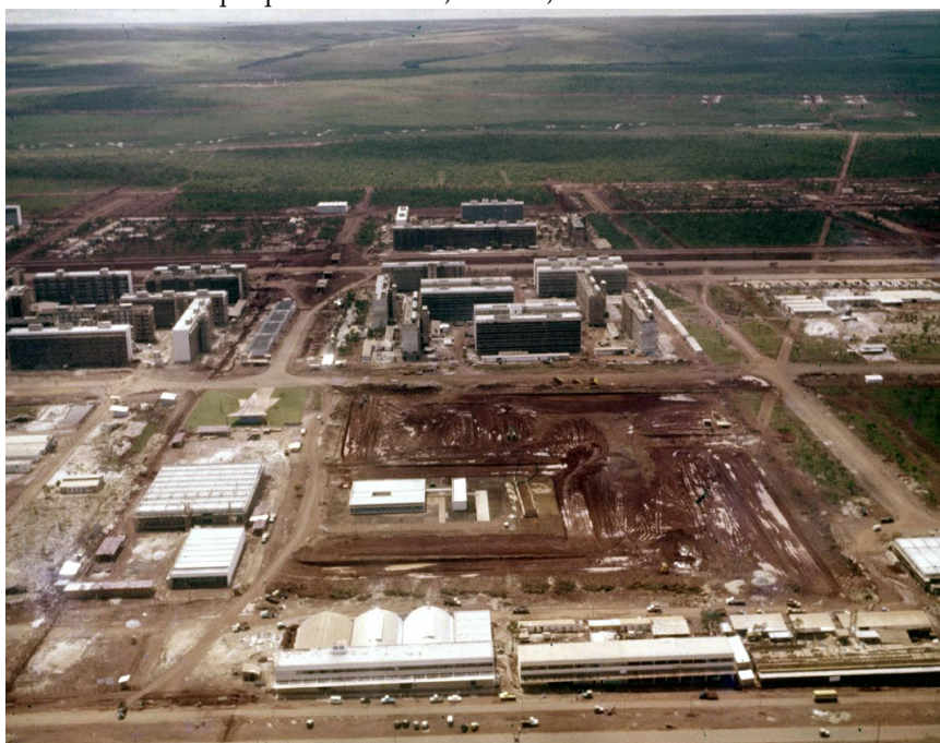
Figura 18: Fotografia da construção das edificações e vias da primeira Unidade de Vizinhança de Brasília, abrangendo as Superquadras 107 Sul, 108 Sul, 307 Sul e 308 Sul
