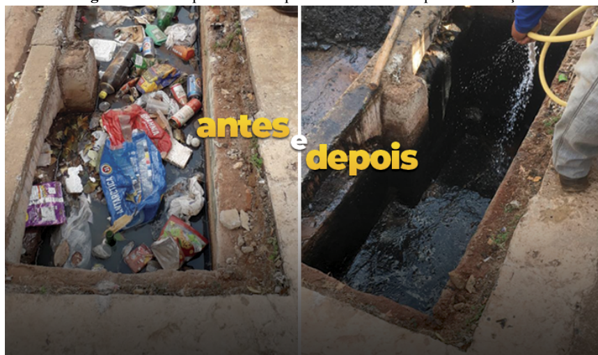
Figura 09: Exemplo de bueiro poluído e o mesmo após manutenção.
