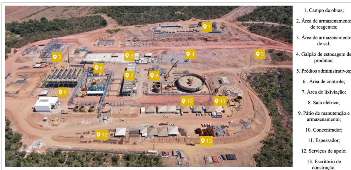
Figura 61 - Visão geral da área de beneficiamento das terras raras pela SVPM, após passar pelos processos de desmatamento e terraplanagem (junho/2022)
