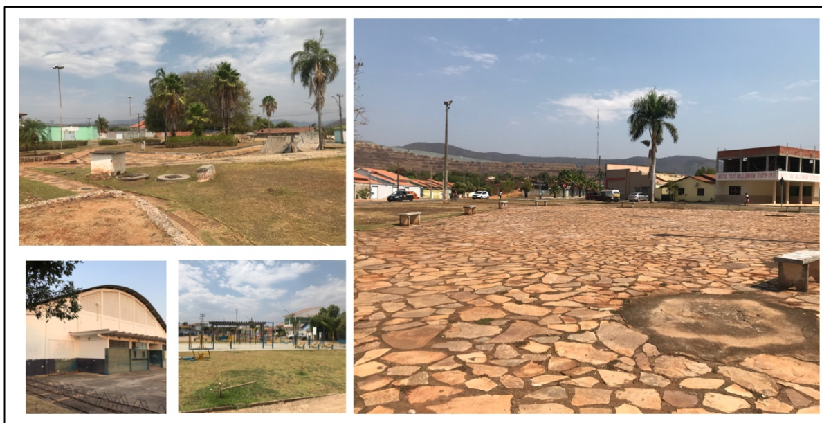
Figura 47 - Condições infraestruturais de equipamentos públicos de Minaçu-GO
