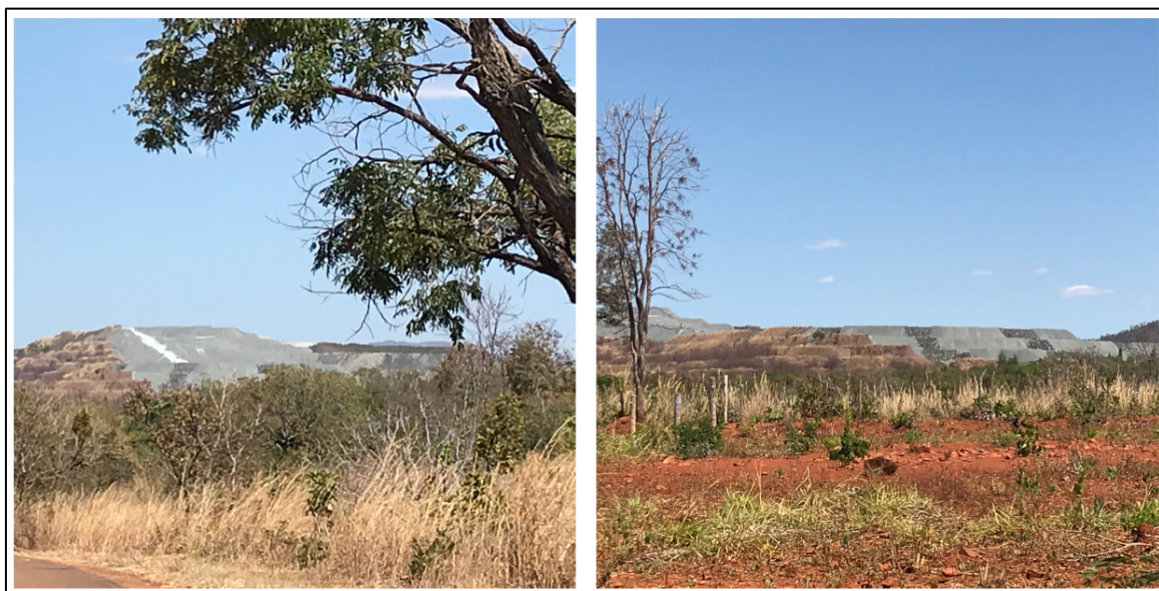
Figura 45 - O “outro lado” das bancadas de rejeito da mineração do amianto crisotila em Minaçu
