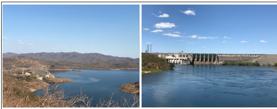
Figura 21 - Usina Hidrelétrica Serra da Mesa, à esquerda, e Cana Brava, à direita
