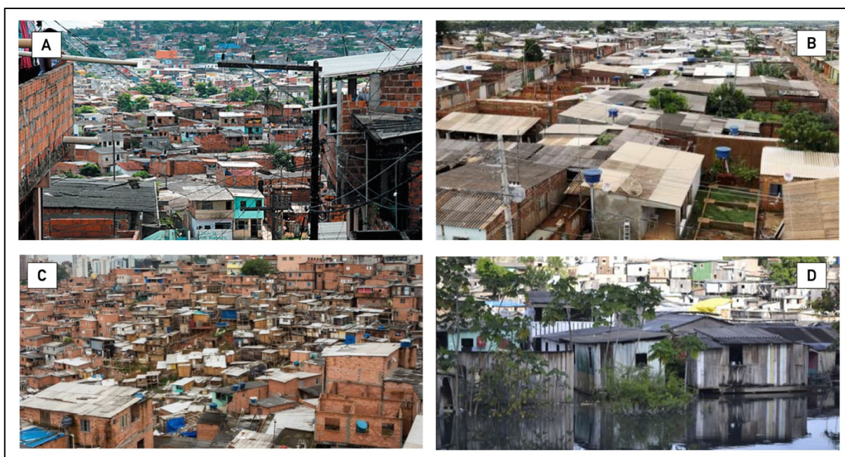
Figura 14 - Predomínio de telhas de fibrocimento na paisagem da periferia urbana brasileira
