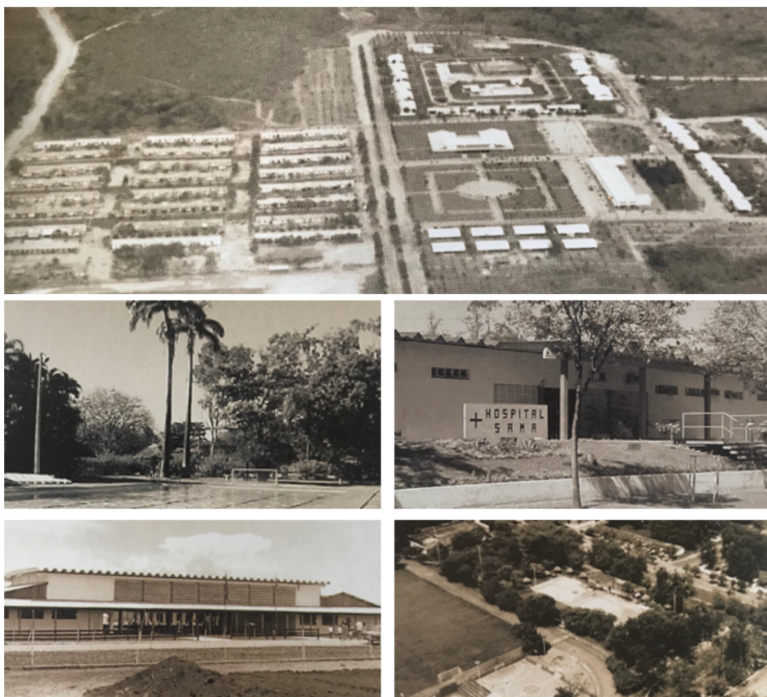
Figura 23 - Infraestrutura da Vila da SAMA (1975-1999)
