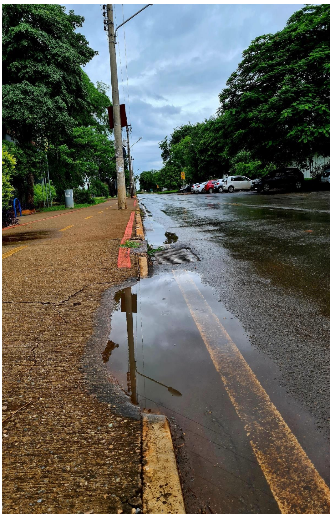
Figura 22 - E no meio do caminho tinha uma poça d'água: rampa de acesso em ciclovia próxima ao RU
