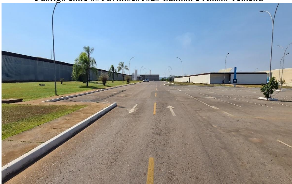
Figura 50 - Carência de elementos arquitetônicos de sombreamento e abrigo entre os Pavilhões João Calmon e Anísio Teixeira
