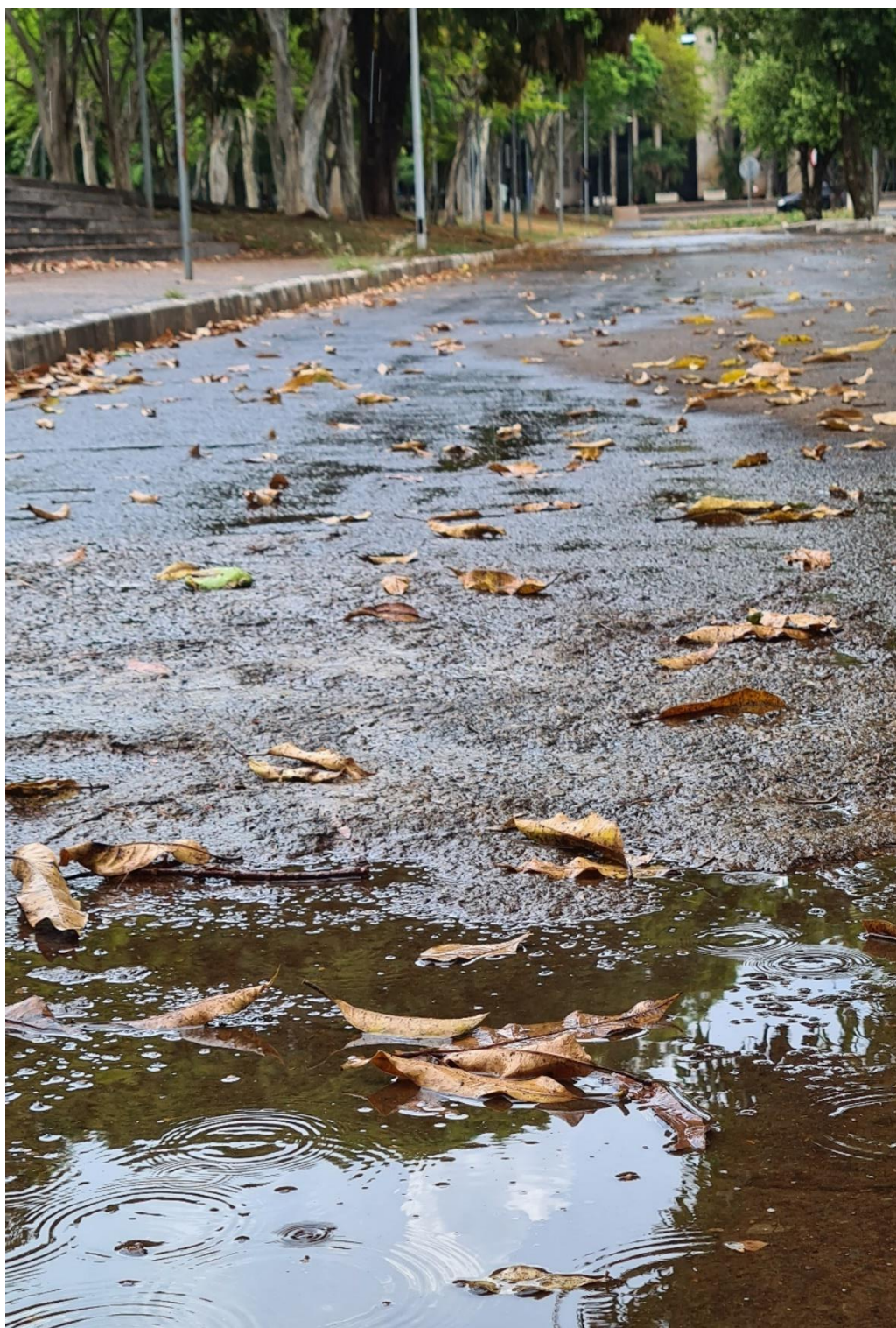
Figura 68 - Fatores de impedância no estacionamento da Reitoria: vegetação e acúmulo de água da chuva
