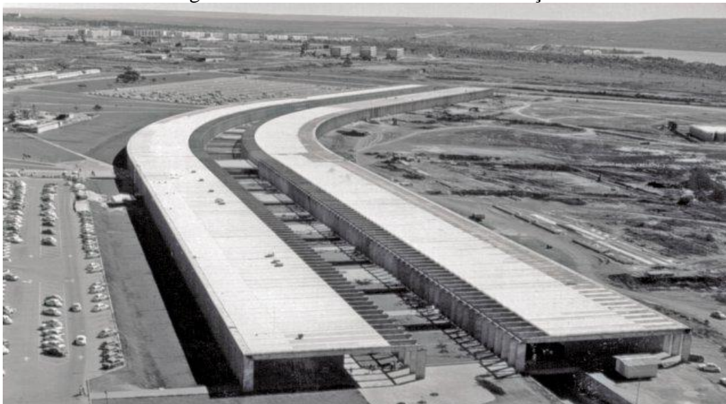
Figura 1 - Vista aérea do ICC em construção
