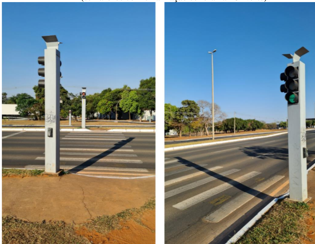
Figura 15 - Entre sons e o direito de ir e vir (semáforos com sinalização sonora na L3 Norte)
