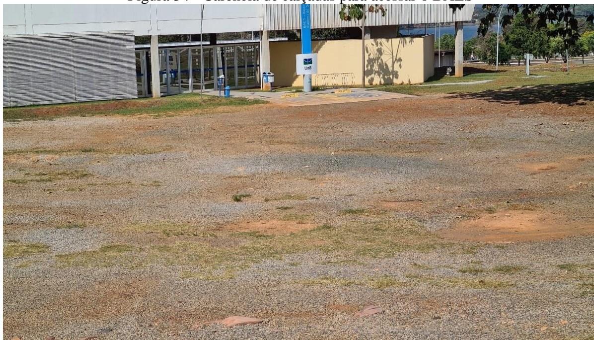
Figura 54 - Carência de calçadas para acessar o BAES
