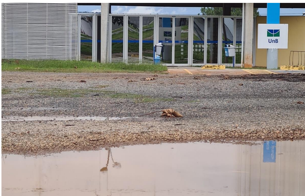
Figura 57 - A falta de infraestrutura pós-chuva
