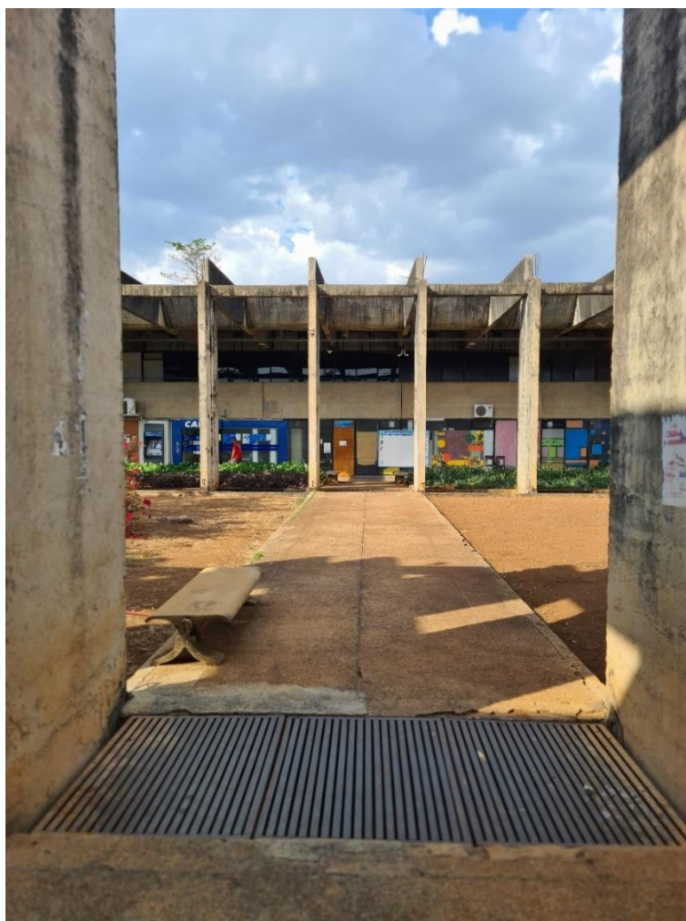
Figura 44 - A travessia do Bloco B ao Bloco A do ICC Sul
