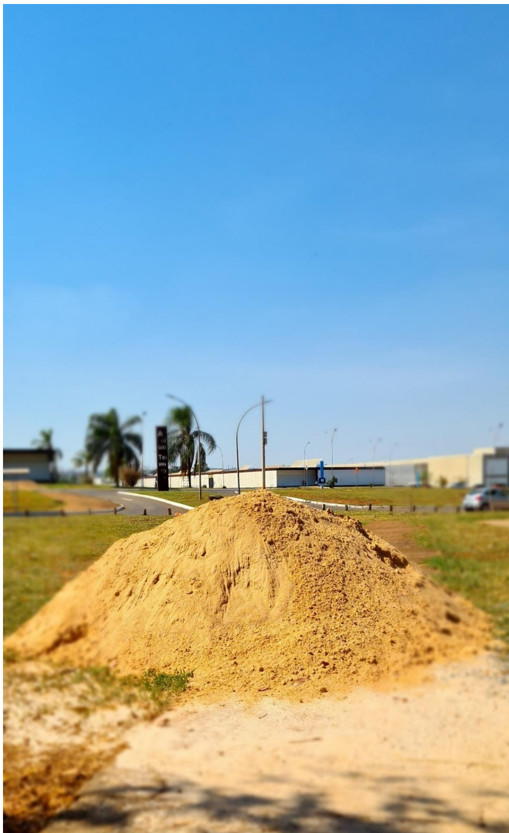
Figura 71 - Um amontado de areia em uma das calçadas que dá acesso aos Pavilhões e uma parada de ônibus (setembro/2020)
