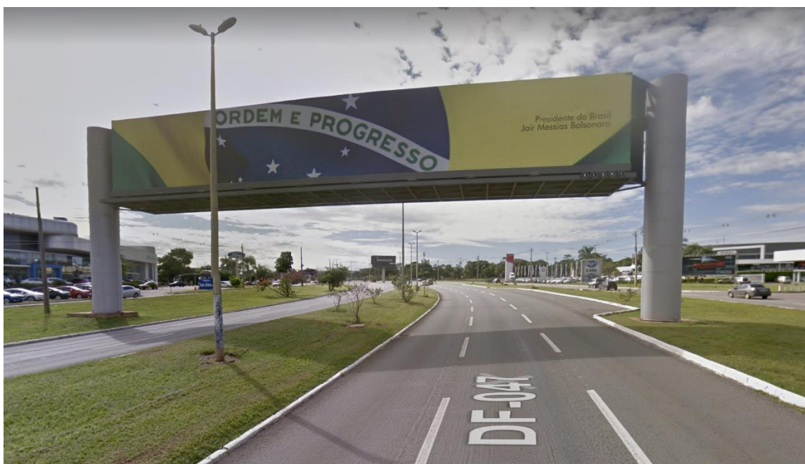
Imagem 1 - Entrada sul de Brasília
