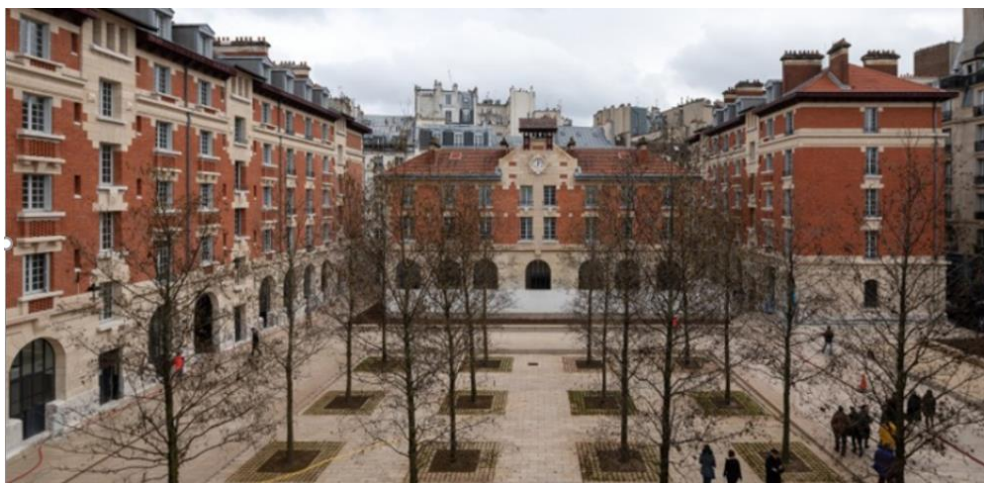
Figura 3. Exemplo de edificação destinada para locação social na França (Fonte: Pavillon de l'arsenal, 2020).
