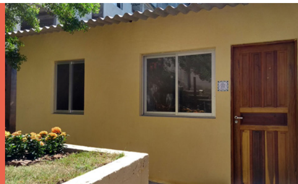
Figura 101: Fachada frontal da residência de Maria Sônia após reforma. Fonte: Ivan Rocha.
