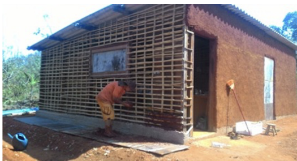
Figuras 107, 108 e 109: Mutirão de enchimento da parede de taipa de mão. Estudantes da UnB-Planaltina. Primeira taipa construída no Rancho de terra. Moradia atual praticamente concluída. Fonte: Gustavina Alves da Silva
