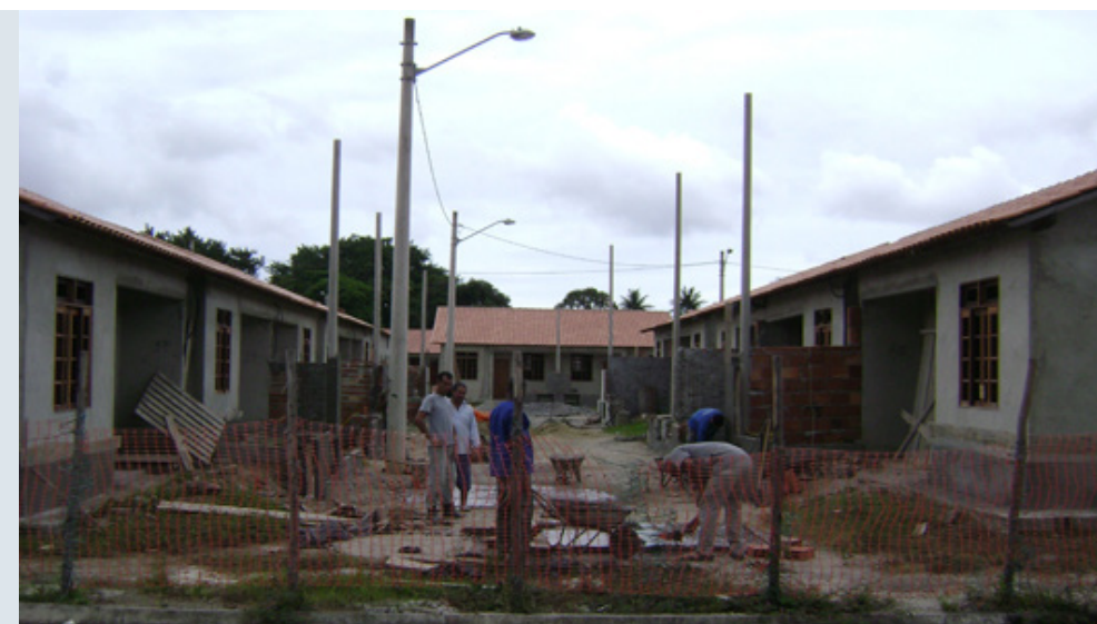
Figura 53: Fase final da obra do Conjunto Esperança em 2015. Fonte: https://rioonwatch.org.br/?p=44304
