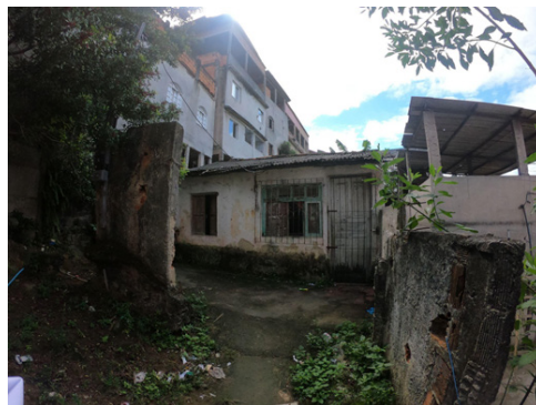
Figura 98: Fachada frontal da residência de Maria Sônia. Fonte: Ivan Rocha.
