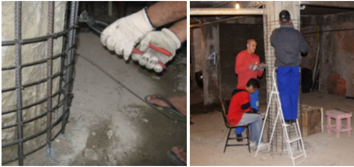
Figura 120: Extensão da vida útil de uma estrutura de concreto armada dos anos 1960, que abriga 42 famílias num condomínio tipo cortiço vertical no centro de São Paulo. (OLIVEIRA et al. , in : Anais do 54º Congresso Brasileiro do Concreto). Fonte: IBRACON, 2012
