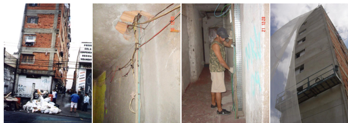
Figura 119: Antes, durante e depois da reforma da fachada. Fonte: REABILITA PCC US p.
