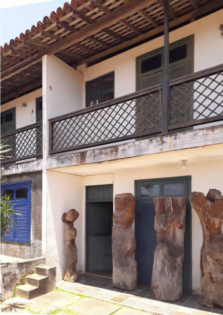
292. Fachada da casa e ateliê de José Cláudio no bairro Monte de Olinda, 2019. Fotografia da autora.
