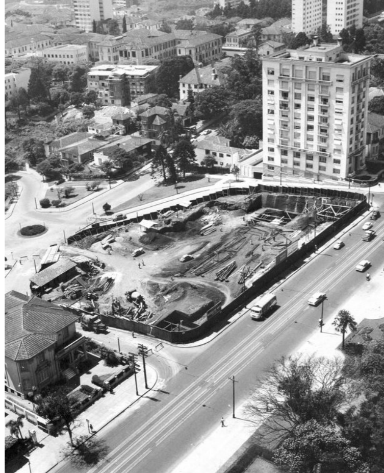
74. Construção do Masp na década de 1950. Fotografia sem autoria especificada. Arquivo do Centro de Pesquisa do MASP, Retirado de Maciel (2018).
