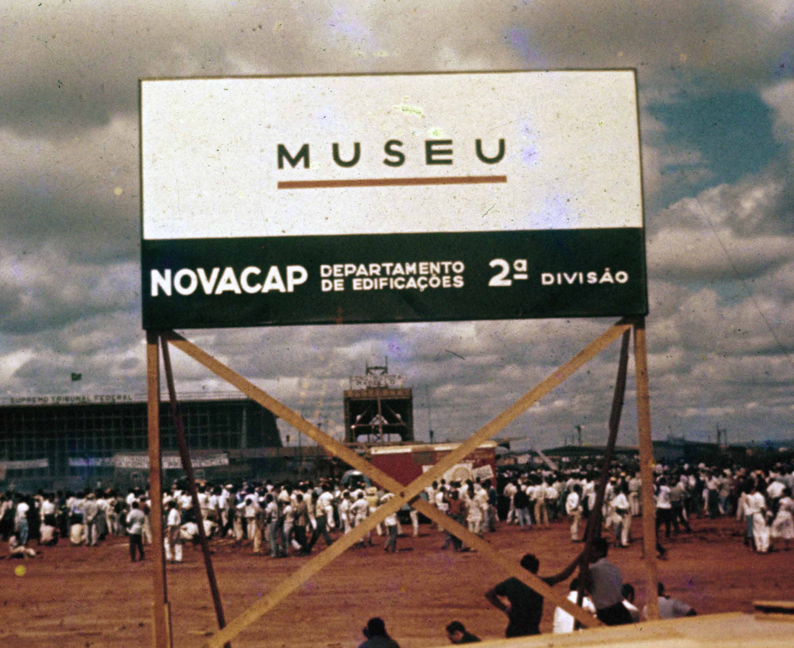
66. Sinalização das obras do museu da cidade, na Praça dos Três Poderes, 1959. Fotografia sem autoria especificada. Arquivo Público do Distrito Federal, NOV-D-4-4-D-4' (2125),
