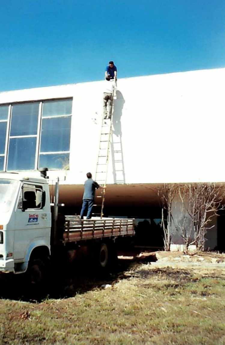
232. Encarregados fazem reparos na laje de cobertura do MAB, s.d. Fotografia sem autoria especificada. Museu de Arte de Brasília, Caixa 60, foto nº 2.
