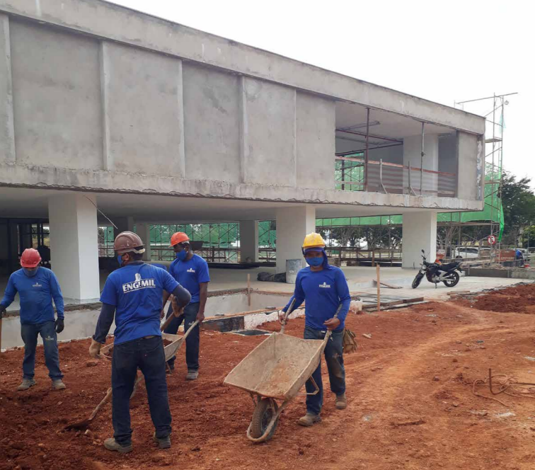
250. Fachada da antiga varanda no início das etapas de acabamento da reforma, maio de 2020.
