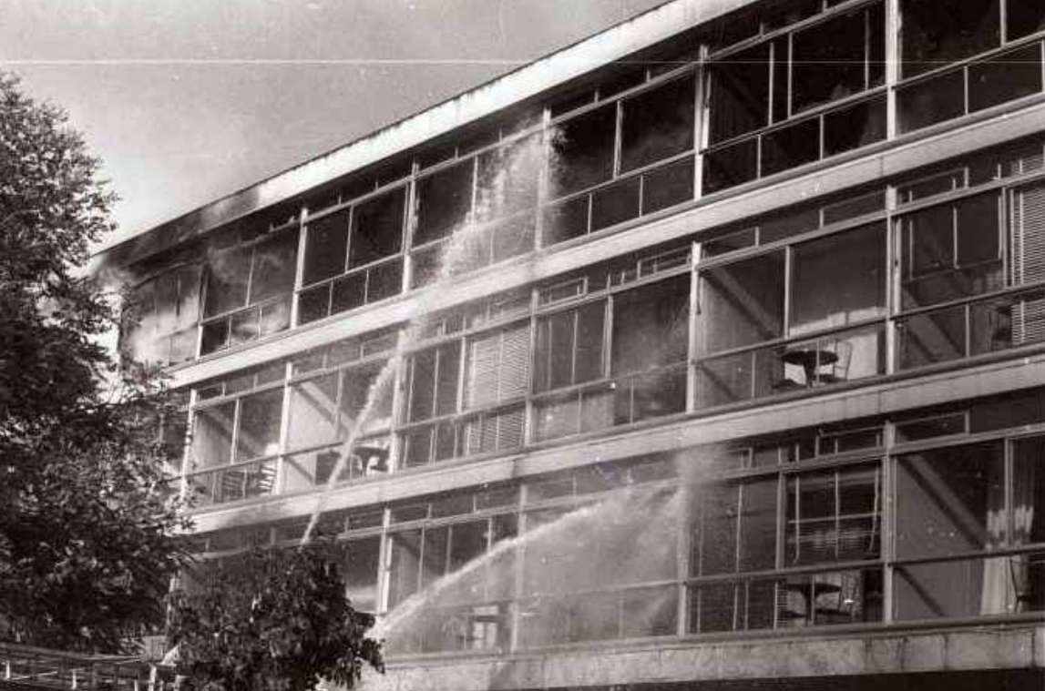
62. Foto da fachada do Brasília Palace Hotel durante o incêndio de agosto de 1978. Fotografia de Antonio Cruz. Retirado de Eufrásio (2018).
