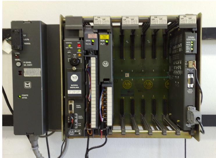
Figura 2.8 - Controlador programável e os módulos analógicos.
