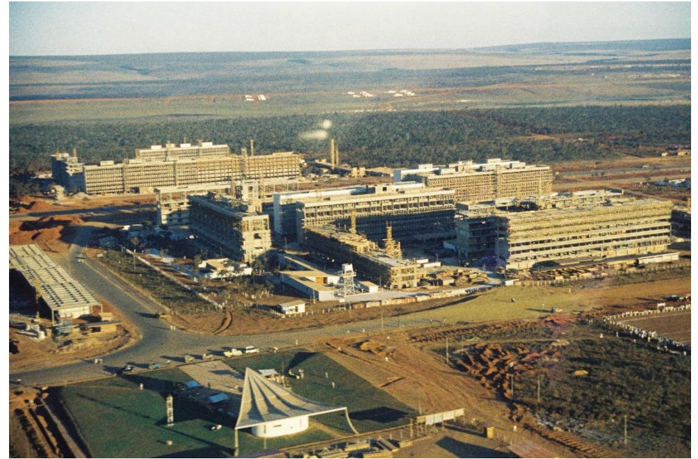
Figura 129 – Imagem aérea da Igrejinha com SQS 108 ainda em construção. Fonte: ArPDF
