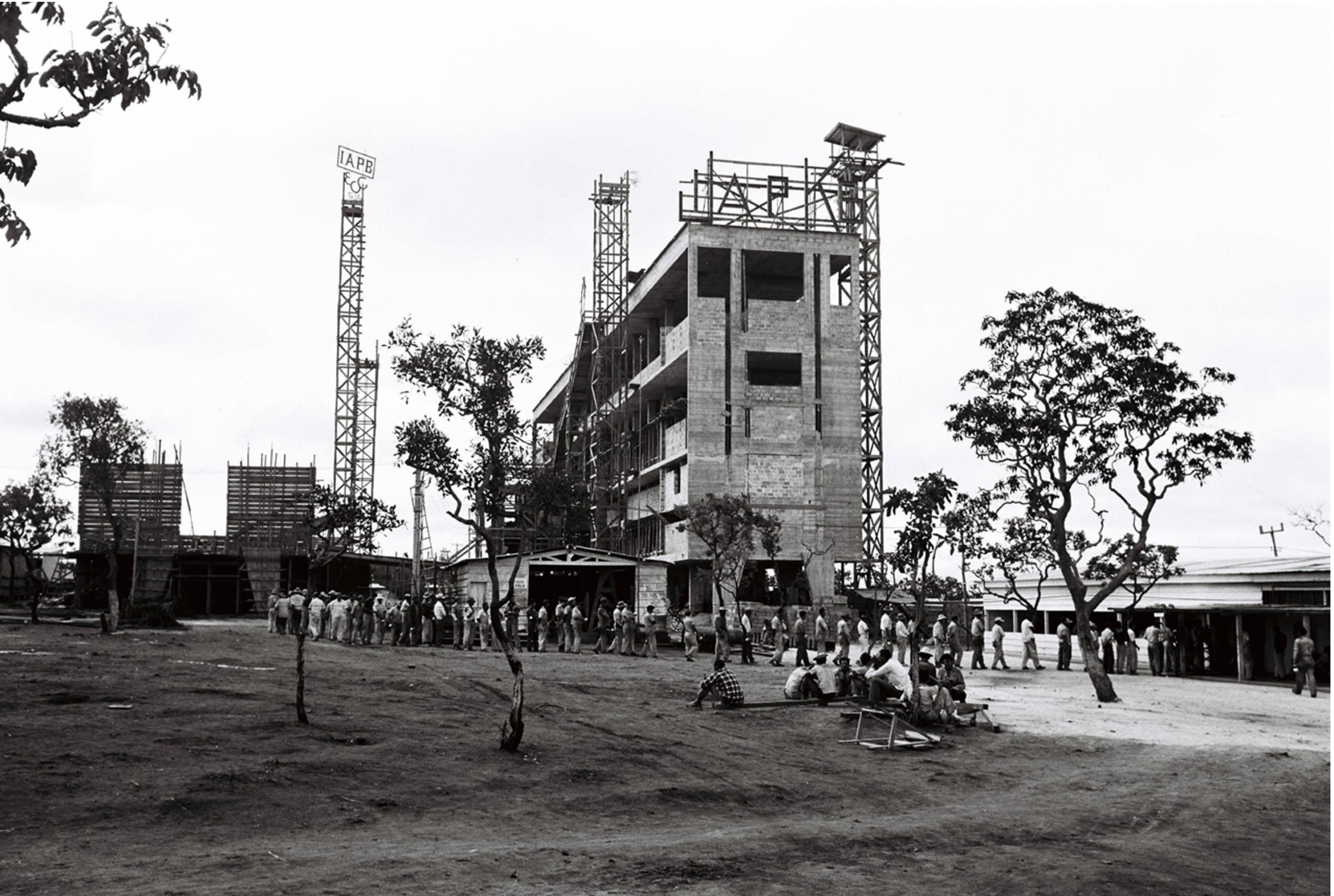
Figura 44 – Foto da construção de bloco do IAPB. Fonte: Arquivo Público do DF
