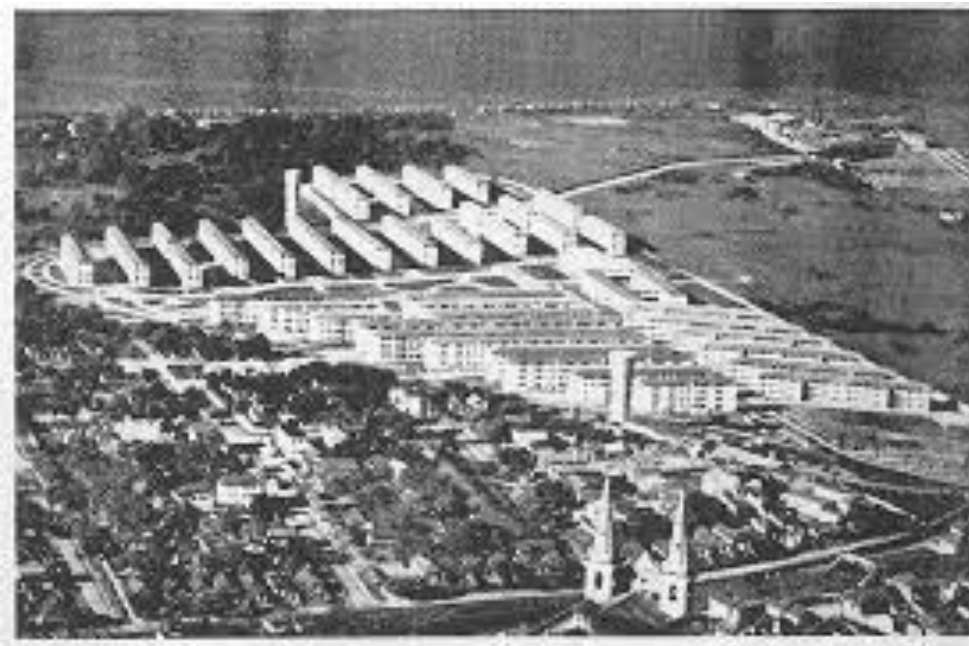
Figura 24 – Conjunto Residencial da Penha (IAPI da Penha). Fonte: Anparq
