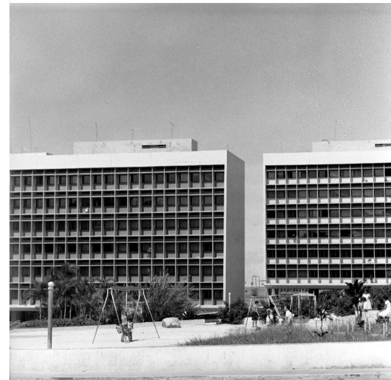
Fig. 51 - Fachadas com brise-soleils. Fonte: Arquivo Público do Distrito Federal
