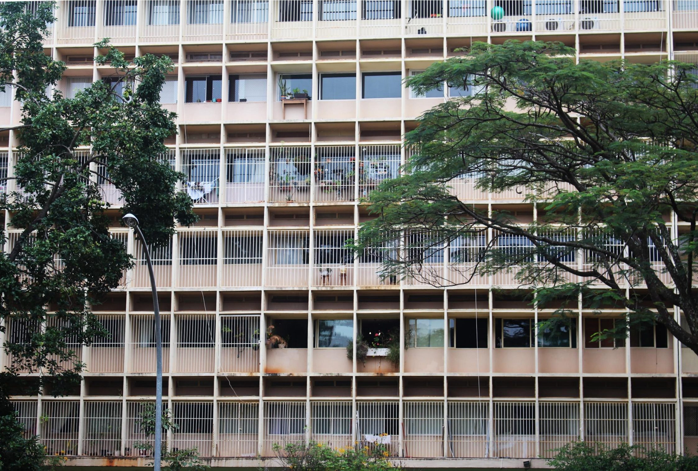
Figura 128 – Ocupação dos brise-soleils em concreto da fachada do bloco F, 2019. Fonte: autora.
