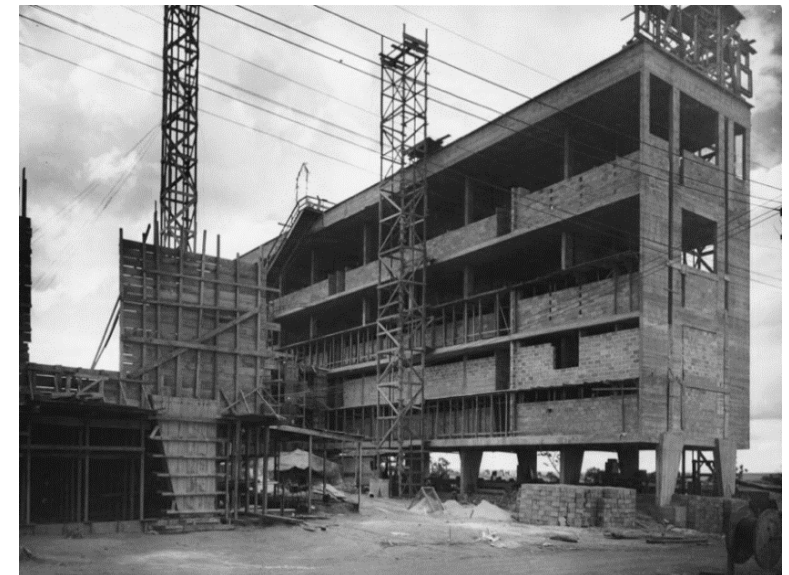
Figura 70 – Construção dos blocos do IAPB. Fonte: Arquivo Público do DF 89
