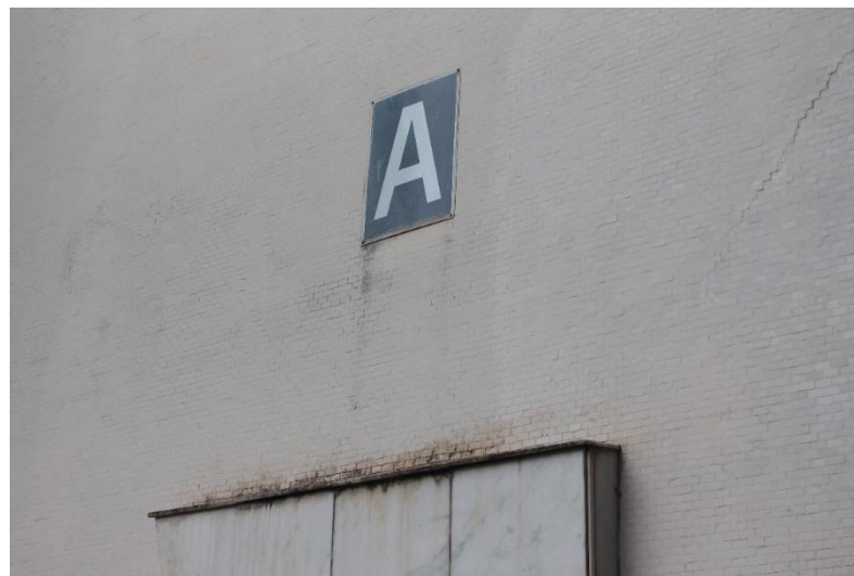
Figura 176 – Sinais da pátina na superfície da empena do bloco A. Foto: autora
