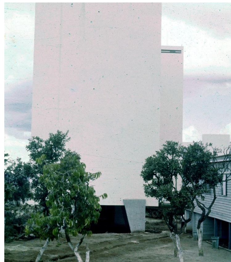
Figura 214 – Empenas brancas e pilares em concreto. Fonte: ArPDF.
