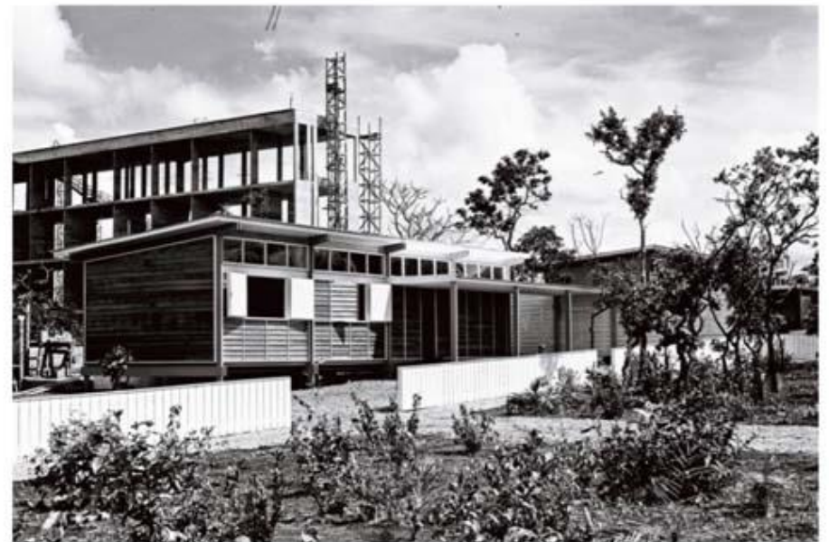
Fig. 76 – Pavilhão de madeira desenvolvido por Lelé para o canteiro de obras da SQS 108. Autor: M. Fontenelle. Fonte: Arquivo Público do Distrito Federal
