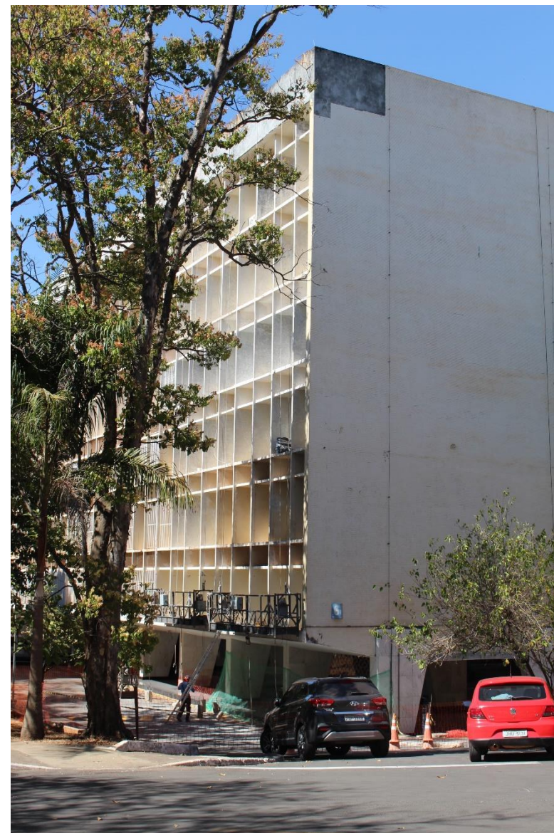
Figura 207 – Intervenções nos brises do bloco G. Fonte: autora.
