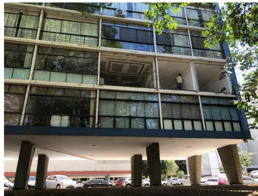
Figura 205 – Intervenções nas esquadrias da fachada do bloco H. Fonte: autora.
