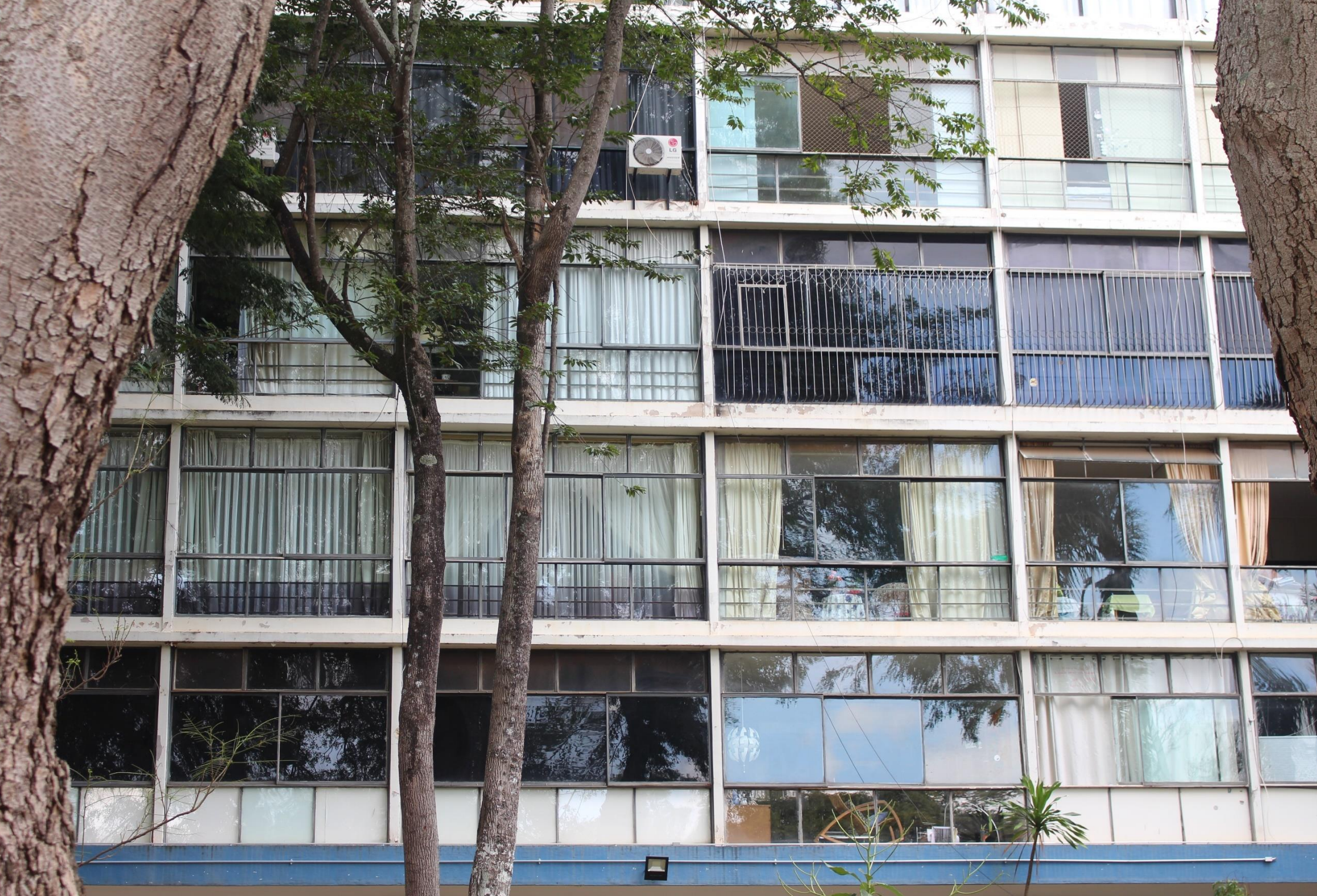
Figura 127 – Fachada envidraçada do bloco H da SQS 108, 2020. Fonte: autora.
