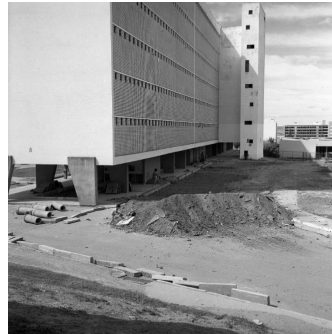
Fig. 194 – Variação de tratamento do plano de cobogós. Fonte: ArPDF
