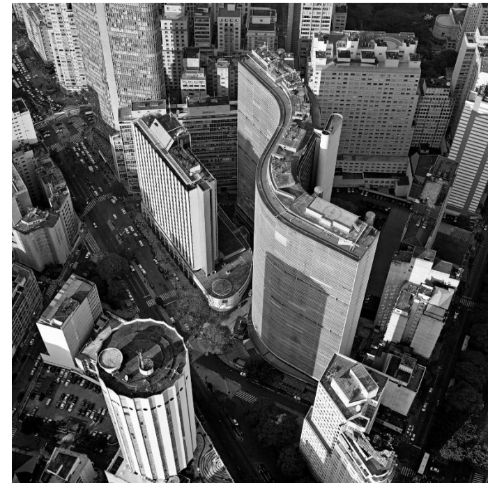
Figura 156 – Edifício Copan, São Paulo. Foto: Nelson Kon
