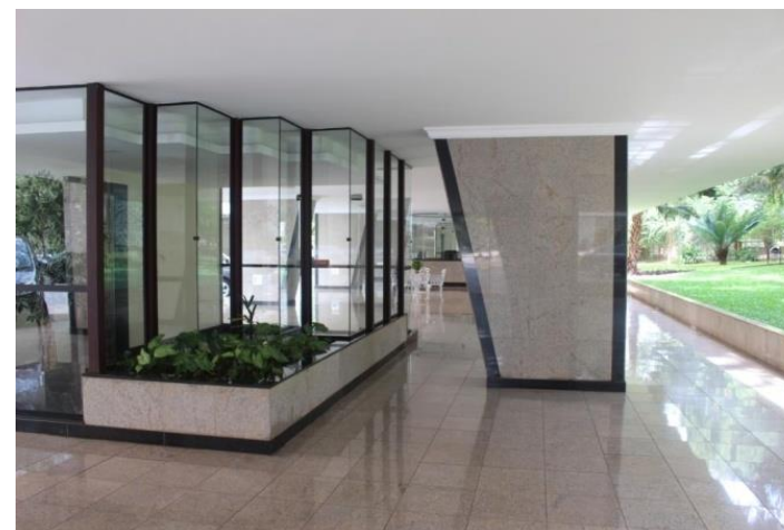
Figura 204 – Intervenções nos pilotis do bloco J. Fonte: autora.
