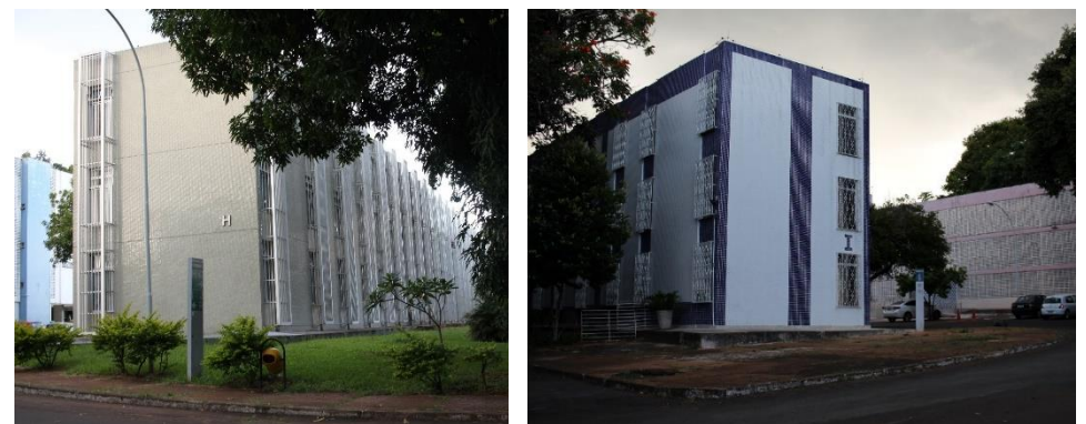
Figuras 171 e 172 – Descaracterização de fachadas de blocos AP-05, 2021. Foto: autora
