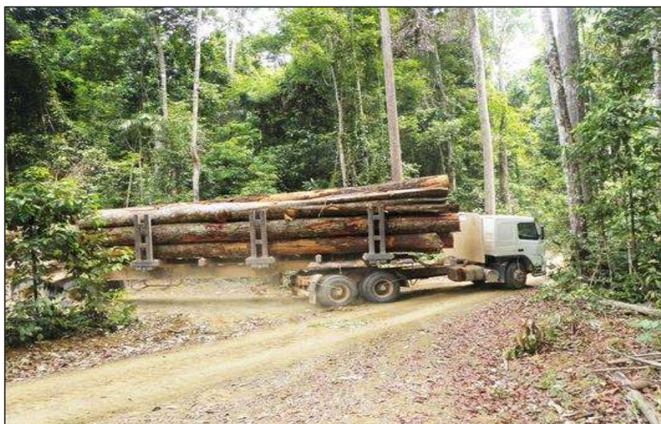
Figura 1.6. Estradas primárias em área de PMFS. Fontes: http://revistaplaneta.terra.com.br .
