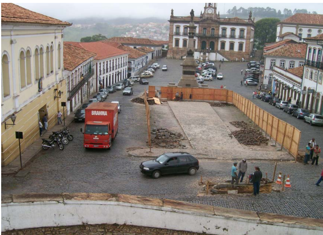
Figura 06 – Detalhe da obra na Praça Tiradentes com caminhão baú. Fonte: Karla Trigueiro, 2008.
