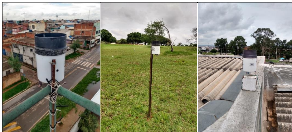
Figura 4.11 - Exemplos de estações de monitoramento pluviométrico instaladas na bacia do Riacho Fundo.
