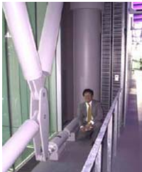
Figura 2.15 - a) Edifício Nihon-Kagaku-Miraikan, Museu Nacional de Ciências Emergentes e Inovações em Tóquio, Japão; b) Instalação do amortecedor MR.
