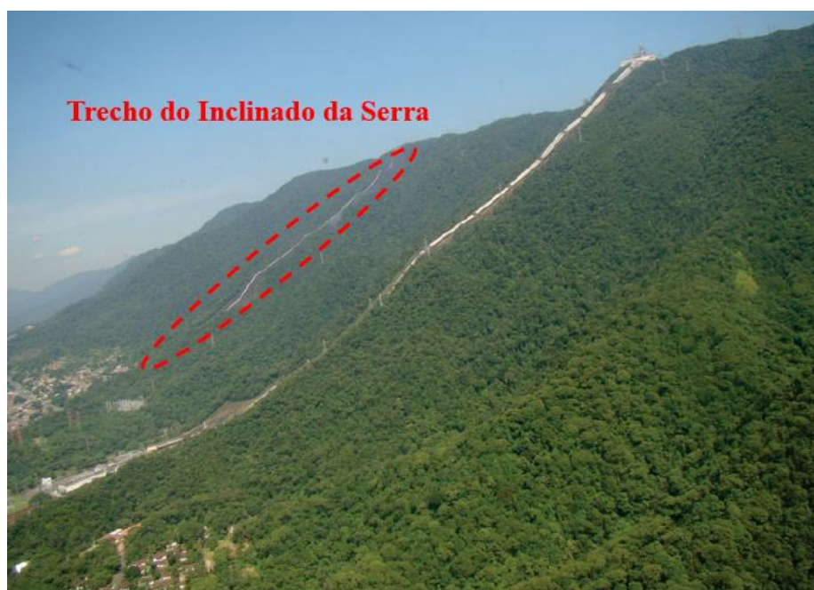
Figura 3.2 – Vista aérea da encosta contendo o trecho estudado (Vieira et al. , 2015 – modificado).
