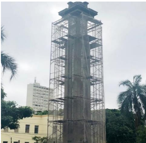
Figura 10. Obra de restauração da Torre. Fonte: Jamyle Amoury/G1 Goiás (2020)
