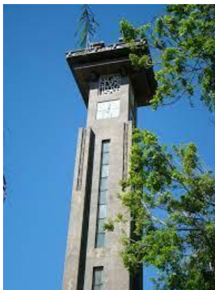
Figura 8. Torre do Relógio, Goiânia – GO. Fonte: IPHAN (2020)
