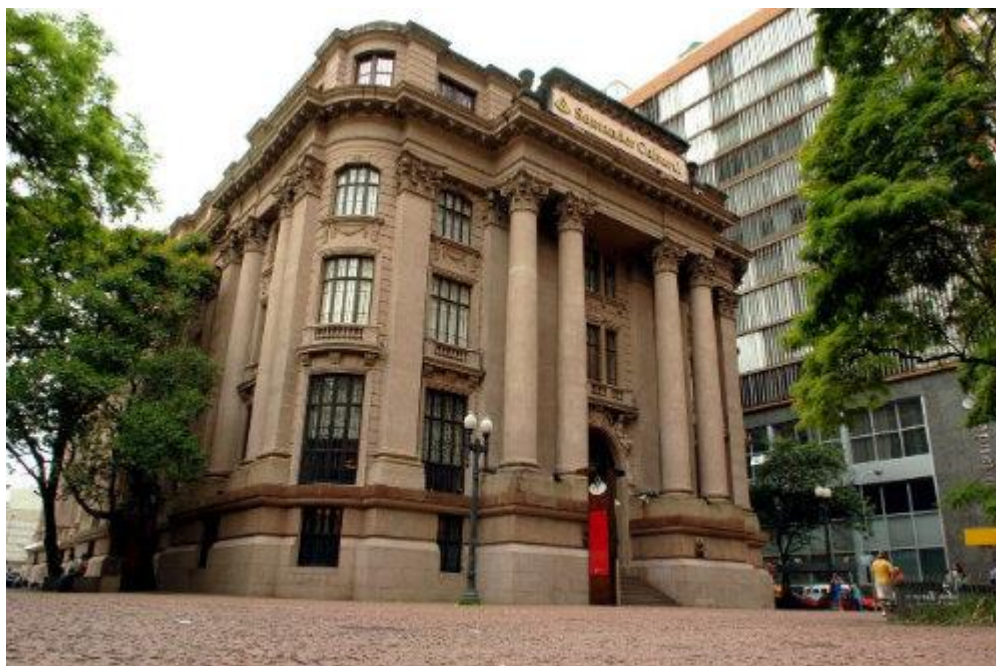
Figura 2 - Fachada do Santander Cultural
