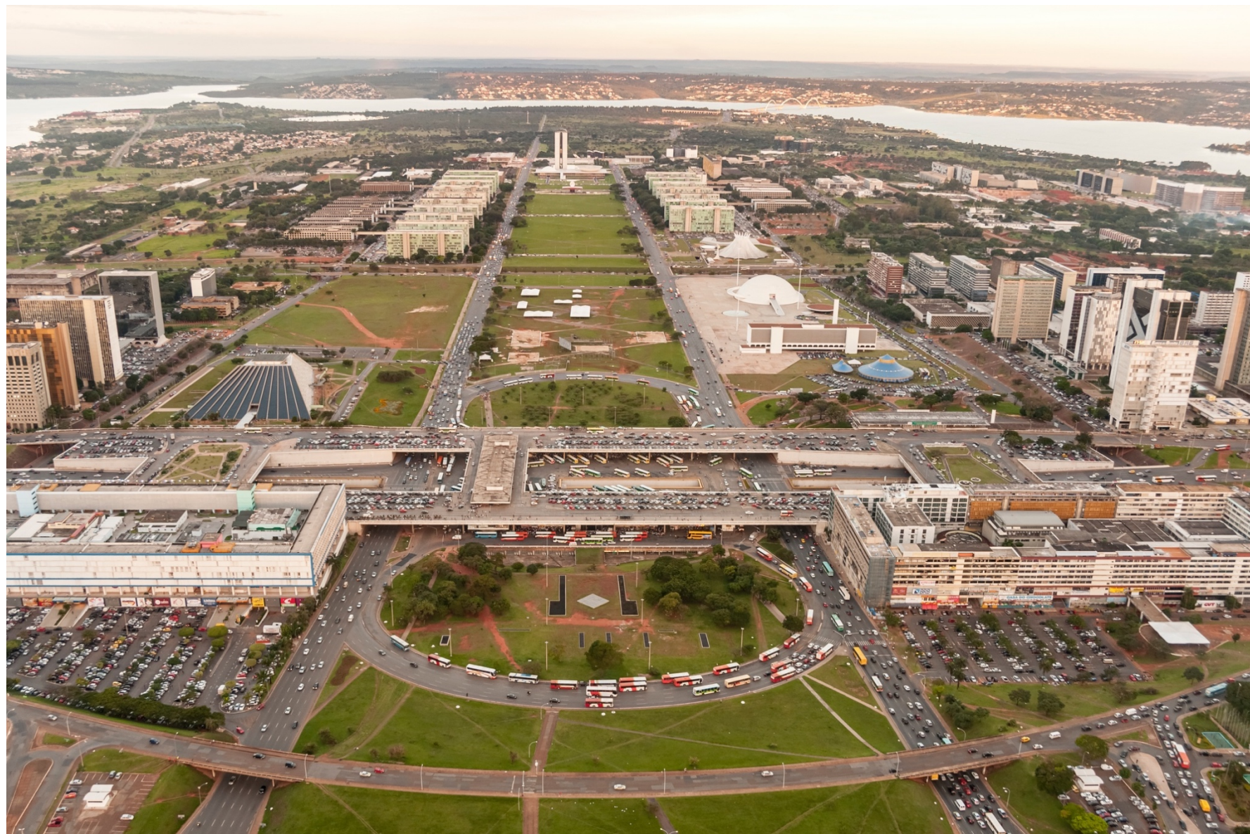
Fig. 65. À esquerda, em seguida ao Teatro Nacional, ainda permanece o terreno desocupado do Setor Cultural Norte, gerando um distanciamento entre a Esplanada dos Ministérios e a Plataforma Central. Crédito: Joana França, 2010.
