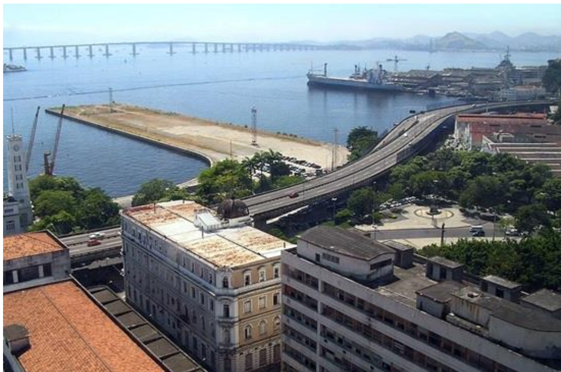
Figura 40 – Região da Praça Mauá antes do projeto de renovação
