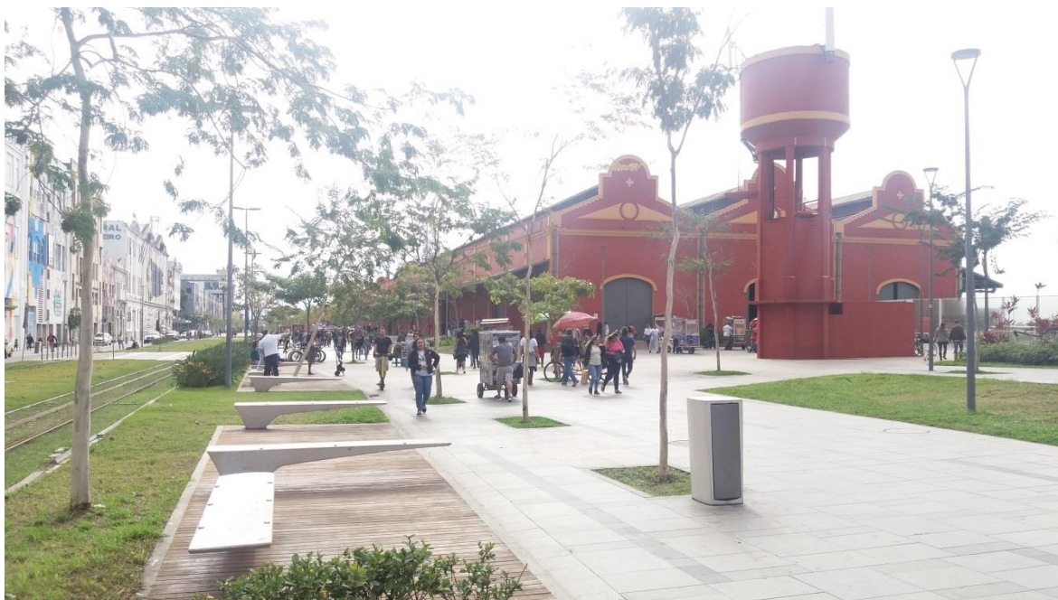
Fotografia 10 – Armazéns renovados do Píer Mauá
