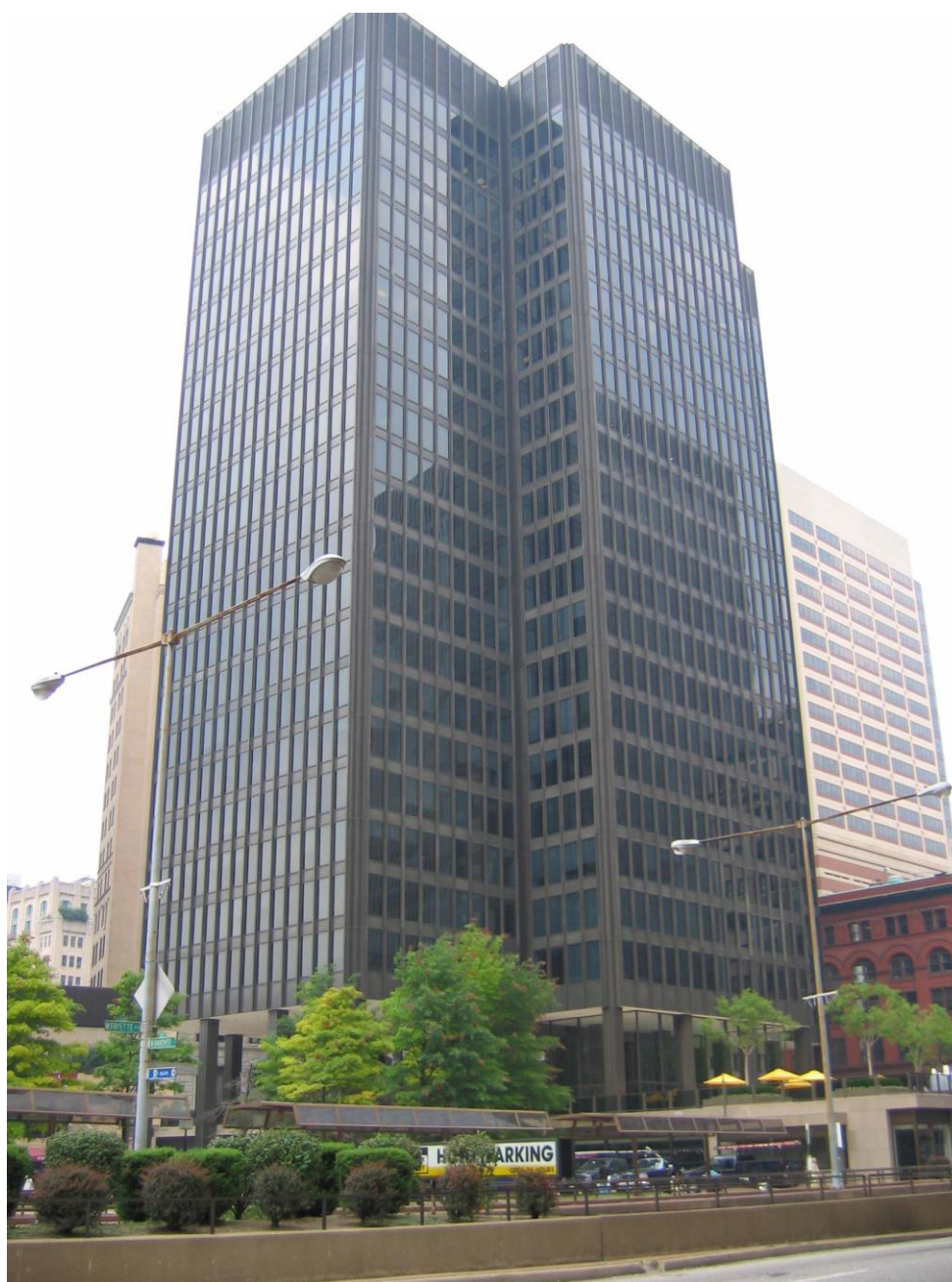
Figura 9 - One Charles Center, edifício âncora do projeto, inaugurado em 1962
