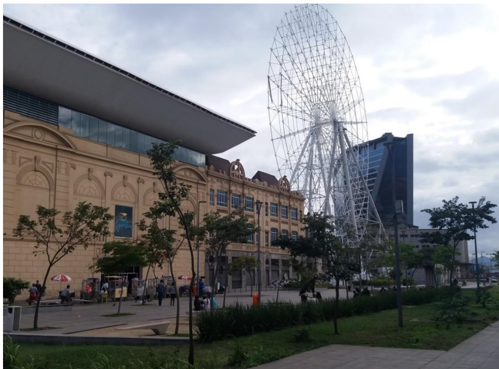
Fotografia 9 – Entrada do AquaRio, com nova roda gigante de 88 metros ao lado
