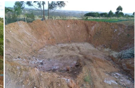
6. Cacimba para captar água de enxurradas
