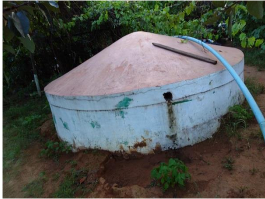
1. Cisterna de placas de cimento
