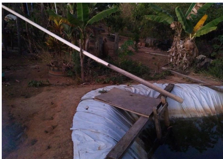
Figura 9 - Sistema de captação de águas pluviais com armazenamento por tanque lonado
