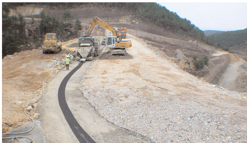
Figura 2.23: Núcleo asfáltico em arco da barragem de Mora de Rubielos (Kolo, 2008).
