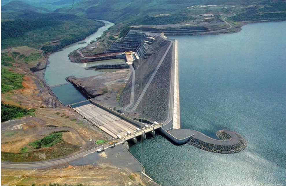
Figura 2.9: Barragem de enrocamento com face de concreto – Barragem de Foz da Areia.
