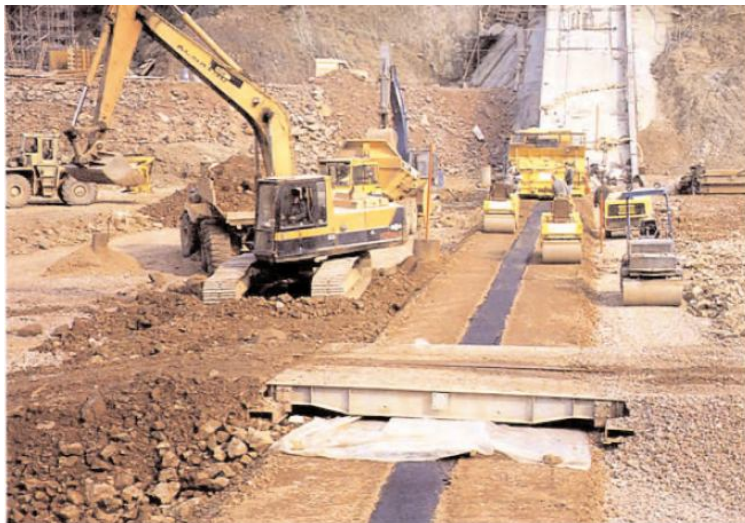
Figura 2.35: Pontes de serviço (Höeg, 2003).
