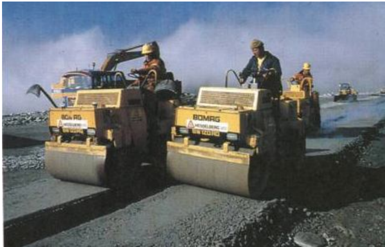
Figura 2.32 - Compactação do núcleo e transições (Höeg, 2003).
