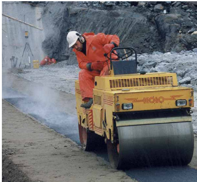
Figura 2.33: Compactação do núcleo asfáltico (Kolo, 2008).
