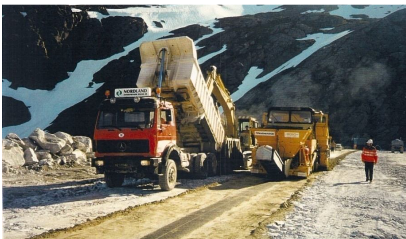
Figura 2.31: Colocação dos materiais de transição na Paver (Kolo, 2003).
