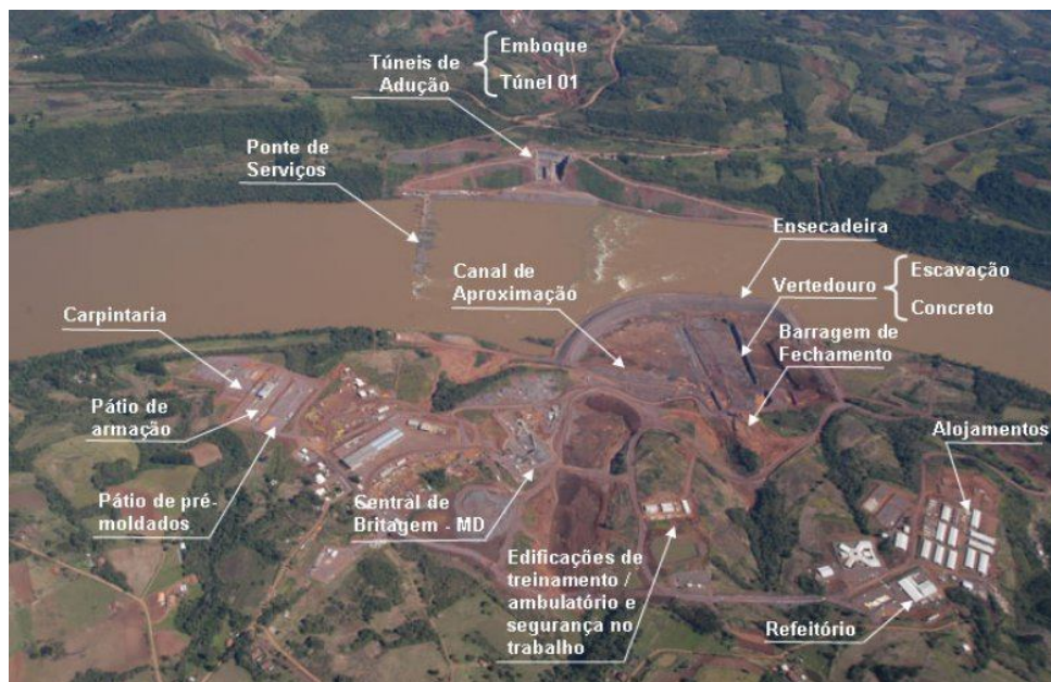
Figura 2.49: Canteiro de obras I - UHE Foz do Chapecó (CEFC, 2008)
