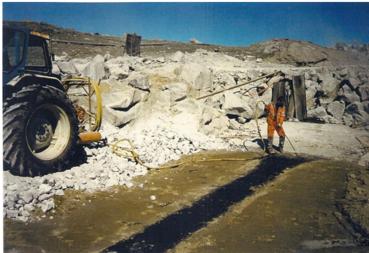
Figura 2.26: Limpeza das estruturas de concreto (Kolo, 2003).
