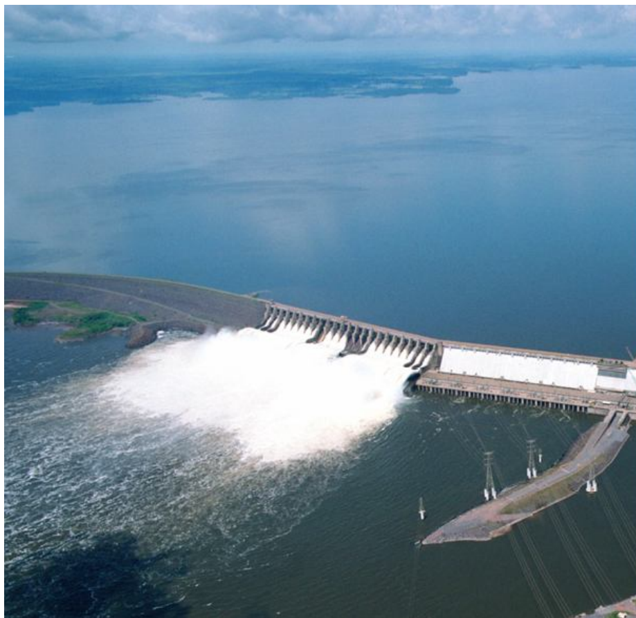
Figura 2.7: Barragem de enrocamento com núcleo compactado – Barragem da UHE Tucuruí (ELN, 2008).
