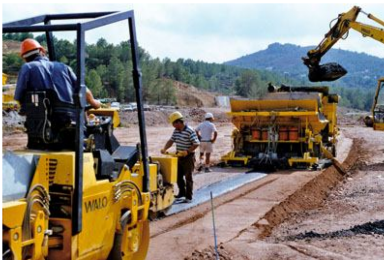
Figura 2.42: Execução do núcleo da barragem de Algar (Walo, 2008).
