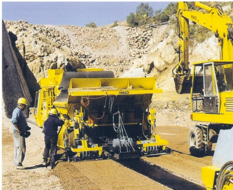
Figura 2.28: Colocação simultânea das camadas de transição e do núcleo (Walo, 2000).
