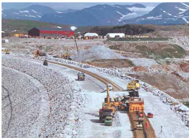
Figura 2.38: Execução do núcleo asfáltico na barragem de Storglomvatn (Kolo, 2003).
