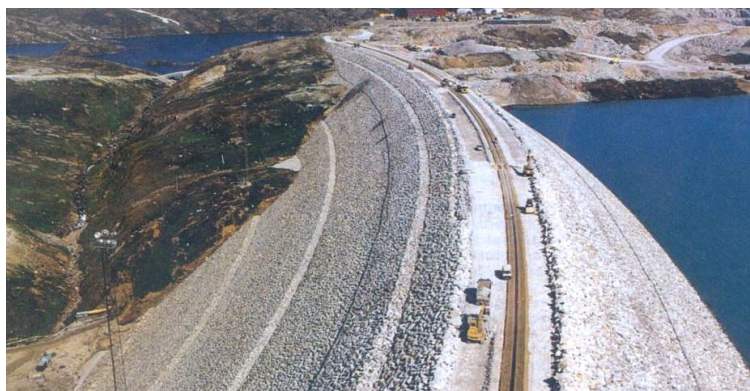
Figura 2.39: Finalização da barragem de Storglomvatn (Kolo, 2003).
