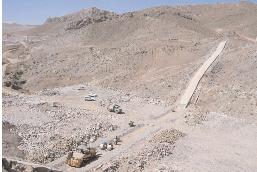
Figura 2.25: Vista aérea do plinto na barragem de Miduk – Iran (Kolo, 2008).
