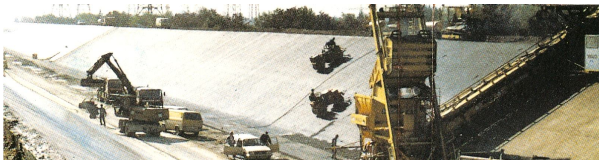
Figura 2.44: Canal de canal Lech, Alemanha (Walo, 1997b).
