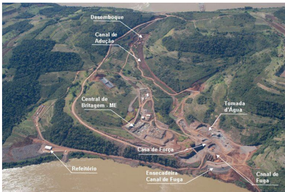
Figura 2.50: Canteiro de obras II - UHE Foz do Chapecó (CEFC, 2008)
