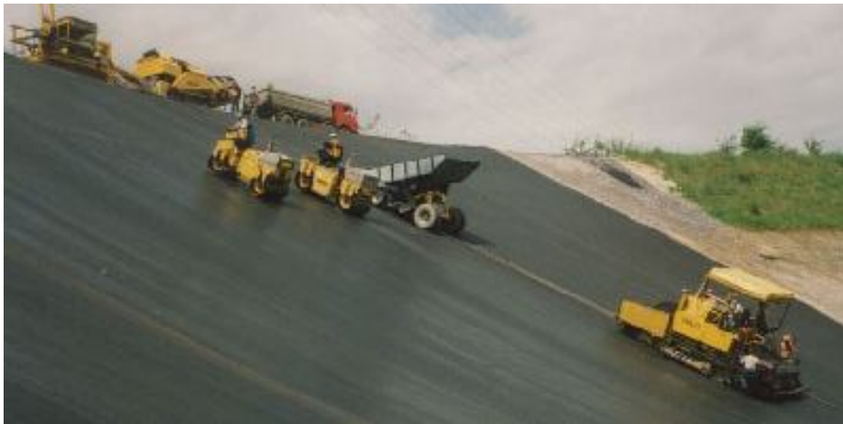
Figura 2.14: Processo de colocação e pavimentação pelo método vertical (WALO, 2008).
