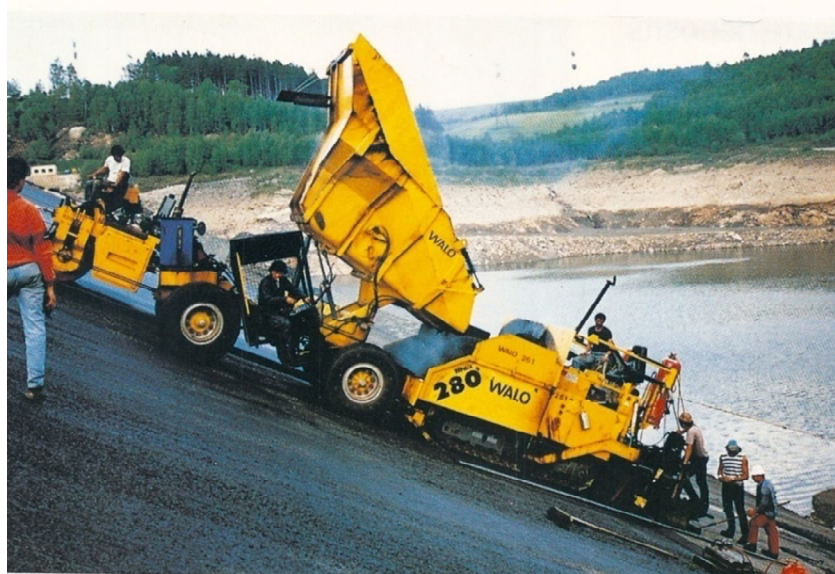
Figura 2.17: Caminhão basculante abastecendo a pavimentadora (Walo, 1994).
