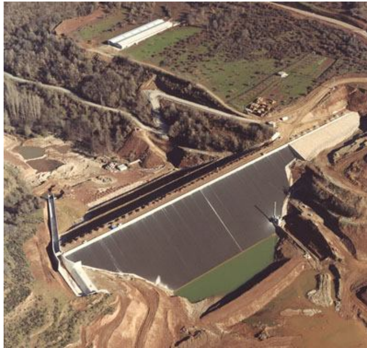
Figura 2.36: Vista superior da barragem de Presa del Yalde/Espanha (Walo, 2008)
