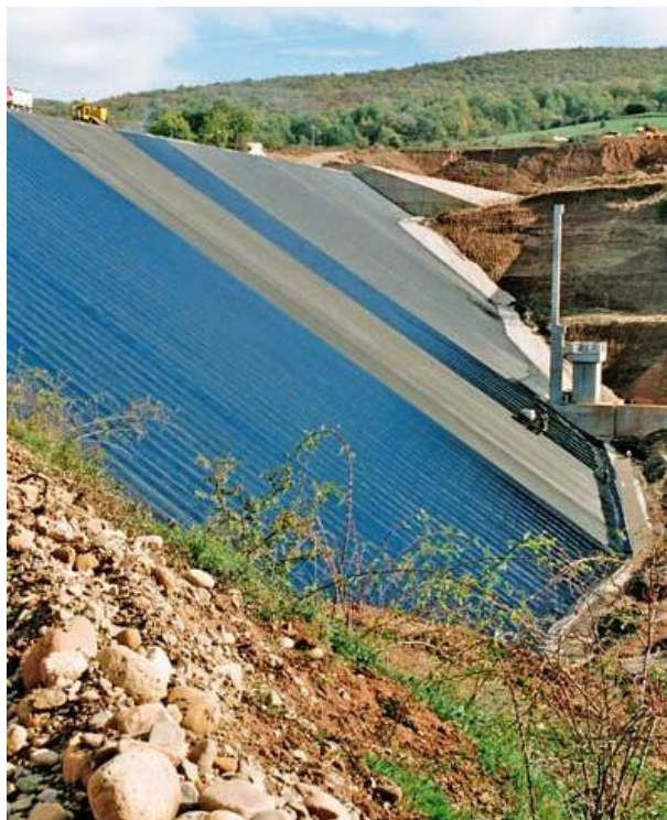
Figura 2.37: Vista do talude de montante da barragem de Presa del Yalde/Espanha (Walo, 2008).
