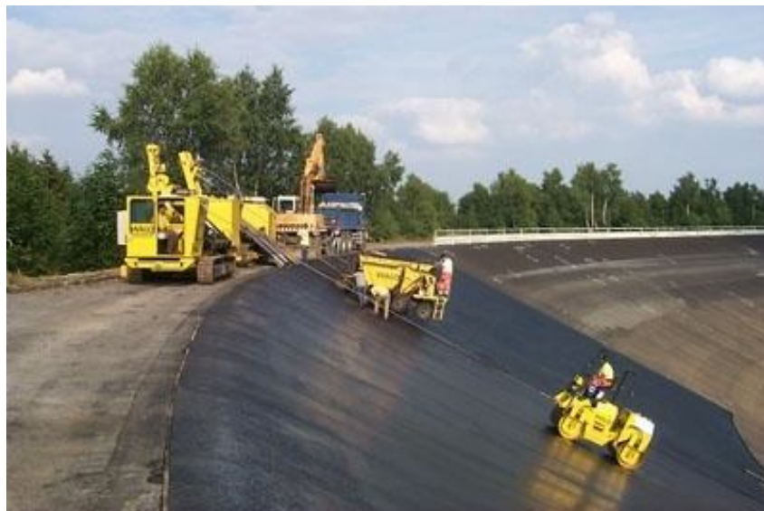
Figura 2.16: Compactação do revestimento por rolos compactadores (Walo, 2008).
