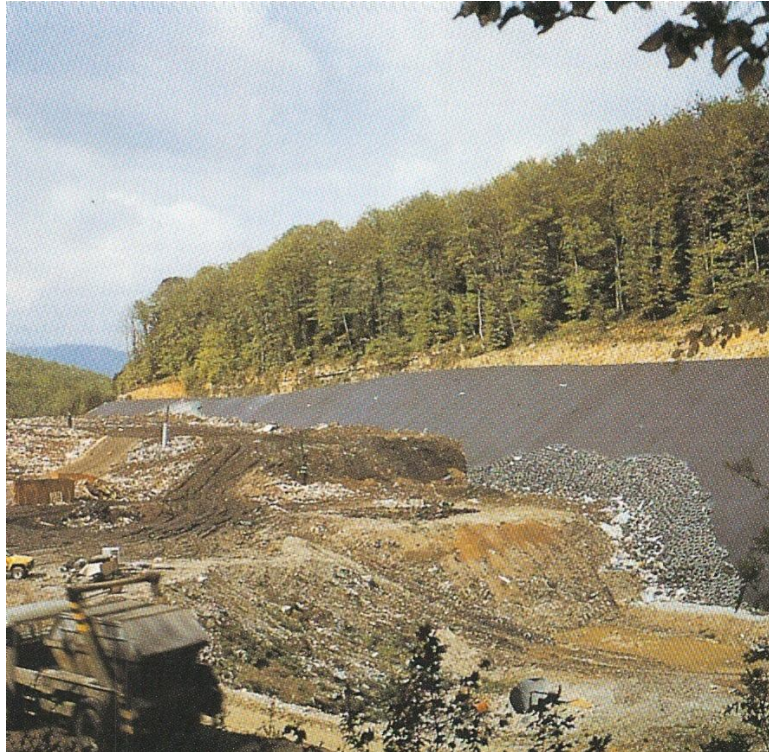
Figura 2.45: Aterro sanitário com face asfáltica/ Valle della Motta (Walo, 2008).
