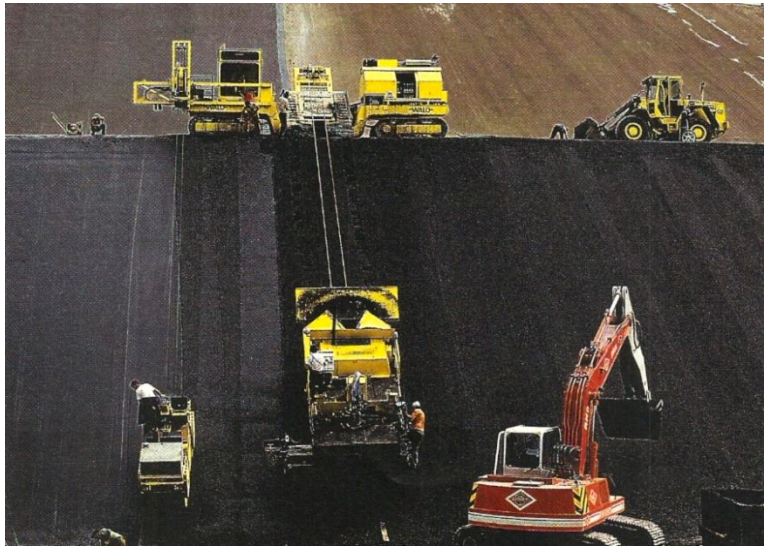
Figura 2.15: Operação da acabadora no método de pavimentação vertical (WALO, 2000).
