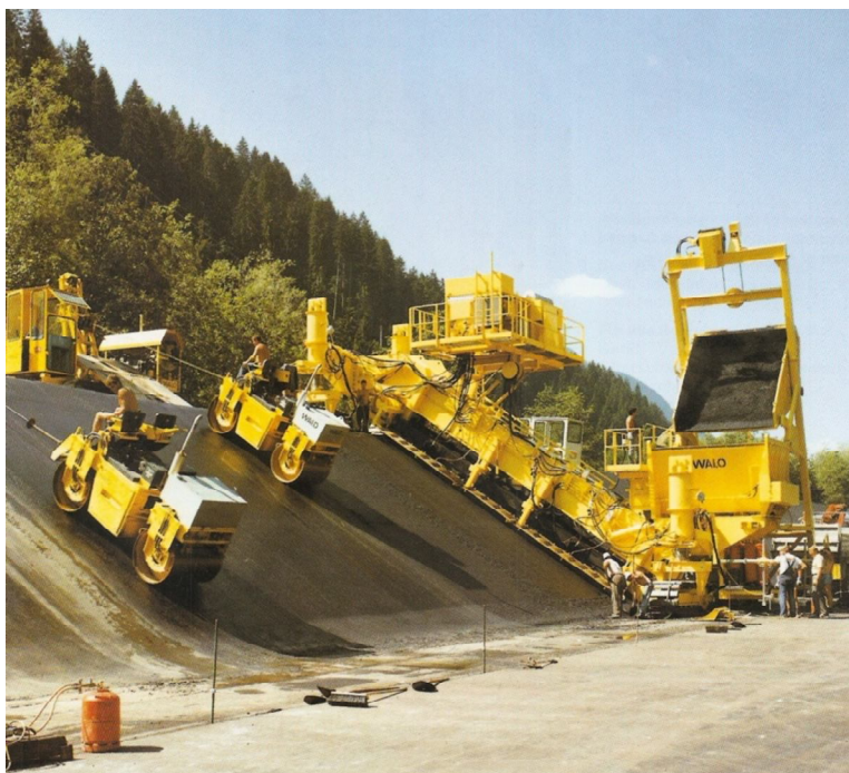
Figura 2.18: Ponte acabadora (Walo, 1997b).
