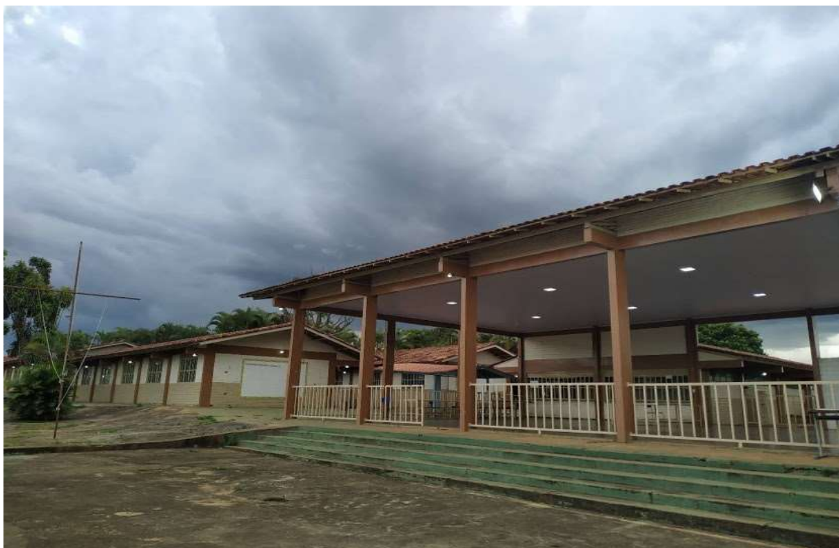
Figura 24 - Pátio do Centro de Ensino Fundamental 09 de Sobradinho
