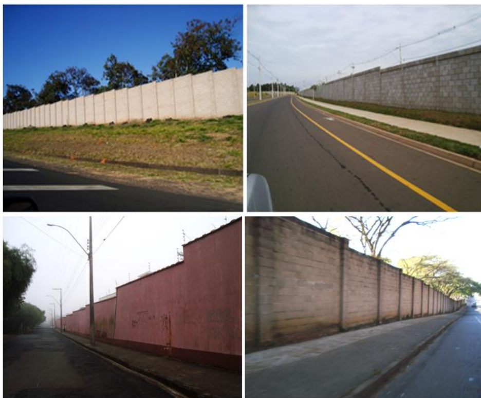
Figura 13 - FALTA DE PERMEABILIDADE – MUROS CEGOS DOS CHFS
