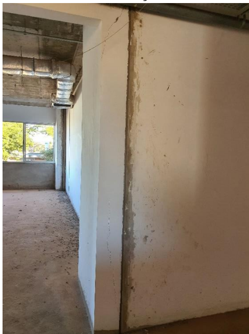
Foto 13 - Junta de Dilatação do 1º Pavimento
