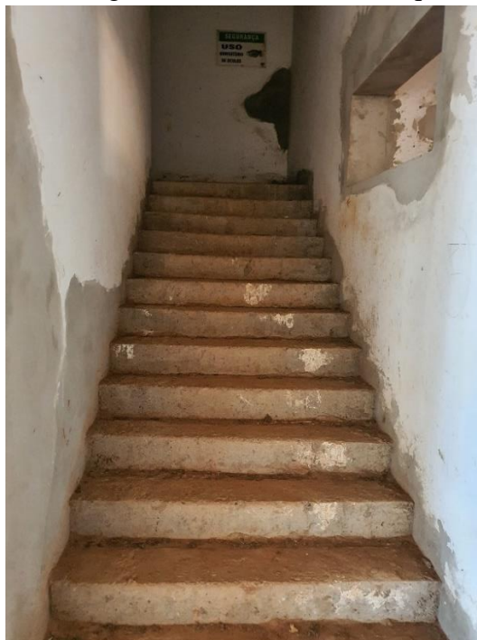
Foto 12 – Degraus da escada do térreo que sobem
