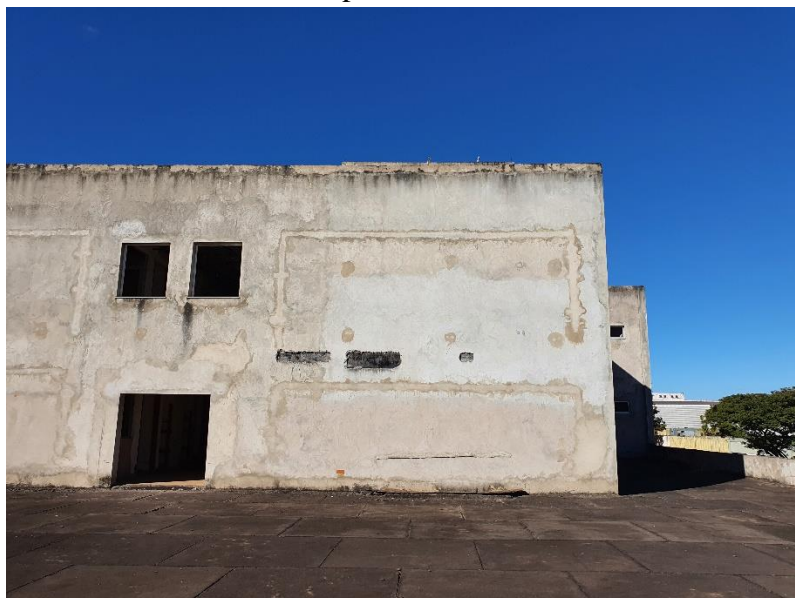
Foto 16 - Contrapiso externo 1º Pavimento
