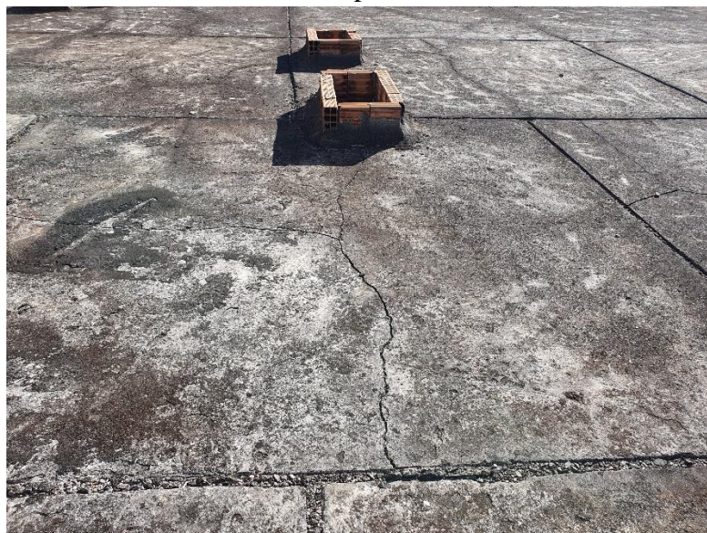
Foto 28 - Contrapiso da Cobertura
