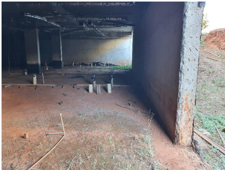
Foto 6 - Instalações hidrossanitárias do Subsolo
