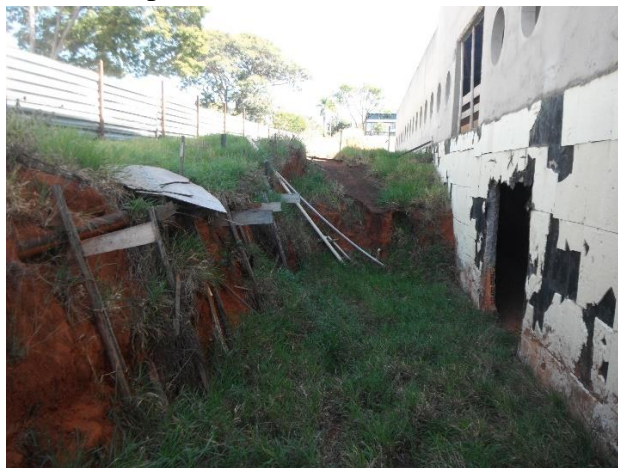
Foto 1 - Saída do subsolo para o térreo, vista externa lado direito da edificação
