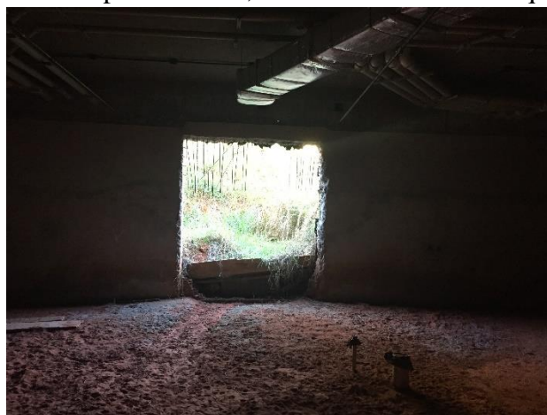
Foto 2 – Saída do subsolo para o térreo, vista interna do lado esquerdo da edificação
