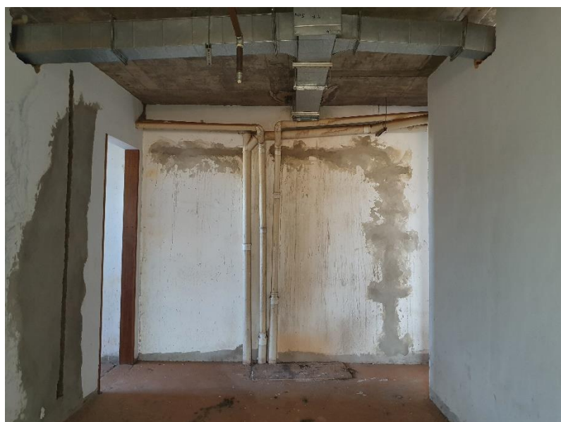
Foto 17 - Pintura/ Base do 1º Pavimento
