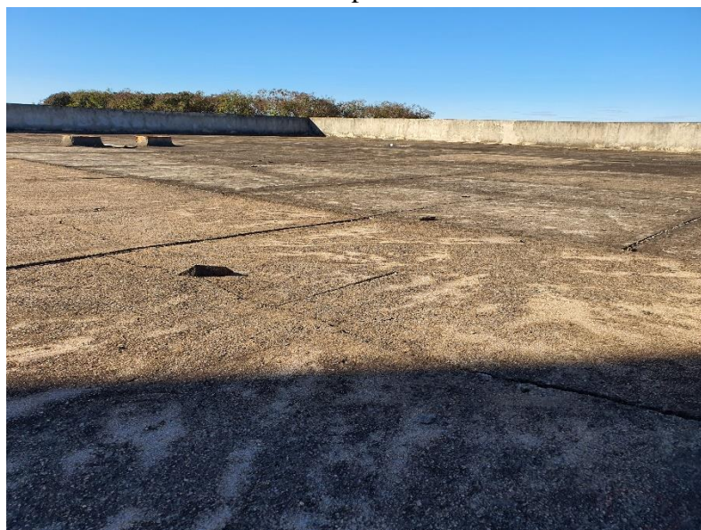
Foto 27 - Contrapiso da Cobertura
