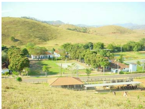
QUADRO 11 – Vista geral da área central do CTAIBB
