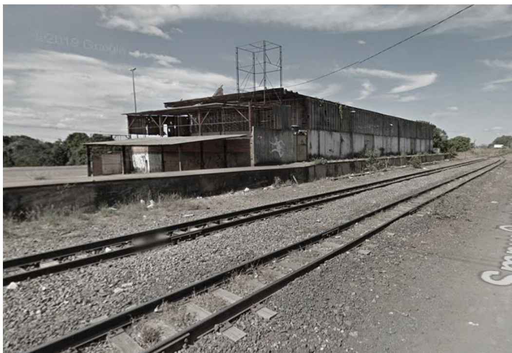
Figura 45. Armazém de Carga da Estação Bernardo Sayão em 2014, onde funciona um lava-jato. Fonte: Imagem capturada pelo Google Street View de jul. 2014. Acesso em 30 de jun. de 2021.
