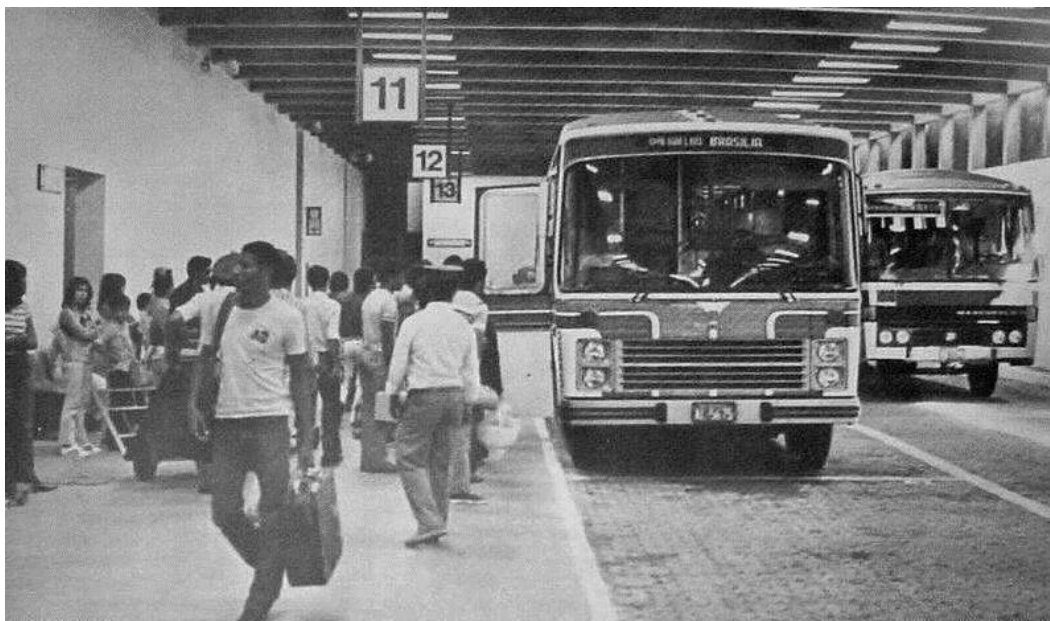
Figura 54. Vista do subsolo da Rodoferroviária em dezembro de 1980. Coleção de Marcelo Almirante. Disponível em: < http://dftrans.blogspot.com/2009/06/rodoferroviaria-em-1980.html > Acesso em 10 nov. 2021.
