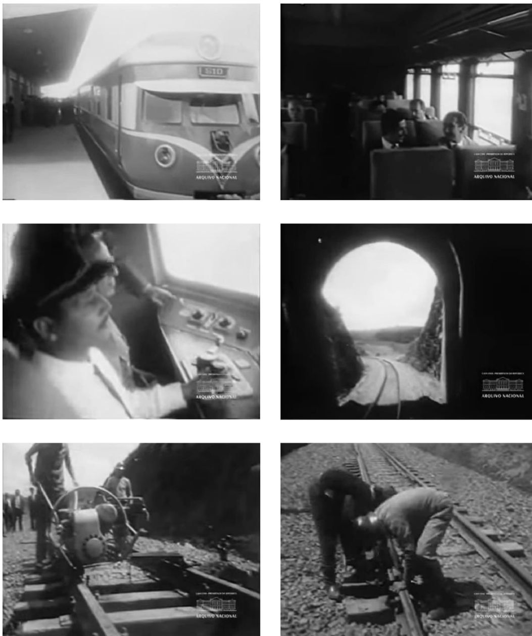
Figura 38. Quadros capturados pela autora do cinejornal produzido pela Agência Nacional mostrando as obras de construção da ferrovia ligando Brasília a Porto Alegre. Os dois últimos quadros mostram o assentamento dos últimos trilhos. Fonte: Cinejornal Informativo n° 125 (1968). Arquivo Nacional. Fundo Agência Nacional.
