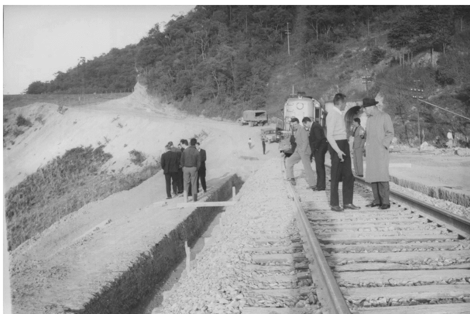
Figura 26. Trabalhos de construção da bitola larga na Estrada de Ferro Central do Brasil (EFCB). 07/1962. Fonte: Fundo Arquivo da Manhã, Arquivo Nacional.
