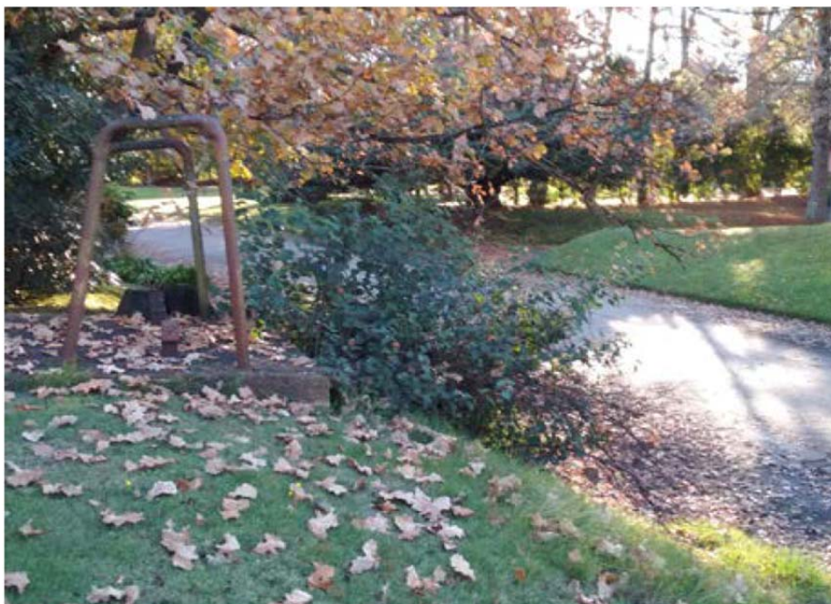
Figura 11: Base de pasarela. Foto tomada por la autora en Julio de 2018.
