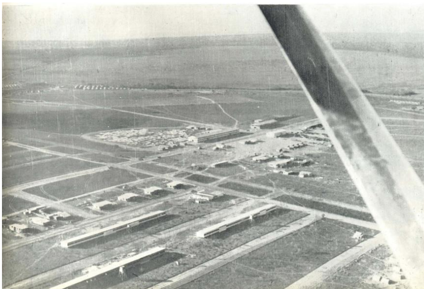
Figura 53: Vista aérea dos Escritórios Provisórios da Novacap, na atual Candangolândia, em 1957.
