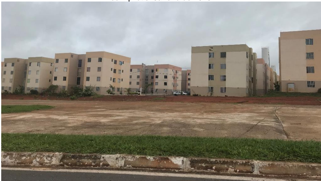
Figura 27 -- Tipologia residencial presente em todo o projeto: Prédios em formato “H” de 4 pavimentos sem pilotis. Janeiro de 2019.
