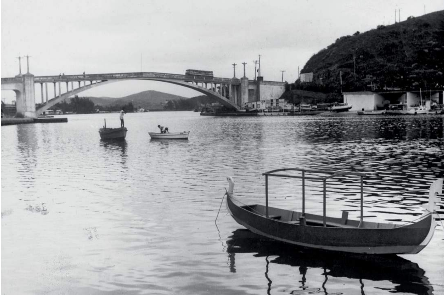
Ponte Presidente Sodré a Cabo Frio, Rio de Janeiro, 1926. Record dei ponti ad arco in calcestruzzo armato. Calcolo di A. Ostenfeld costruzione di Felipe dos Santos Reis e Lino Collet della Christiani &amp; Nielsen. Fonte: Wikimedia Commons.
