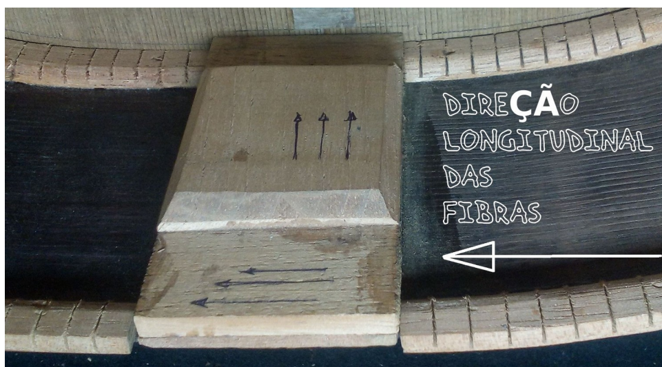
Figura 135: Culatra do violão Martínez/Luthieri de 10 cordas. Direção longitudinal das fibras na junção das laterais com a culatra. Fonte: ALJ.
