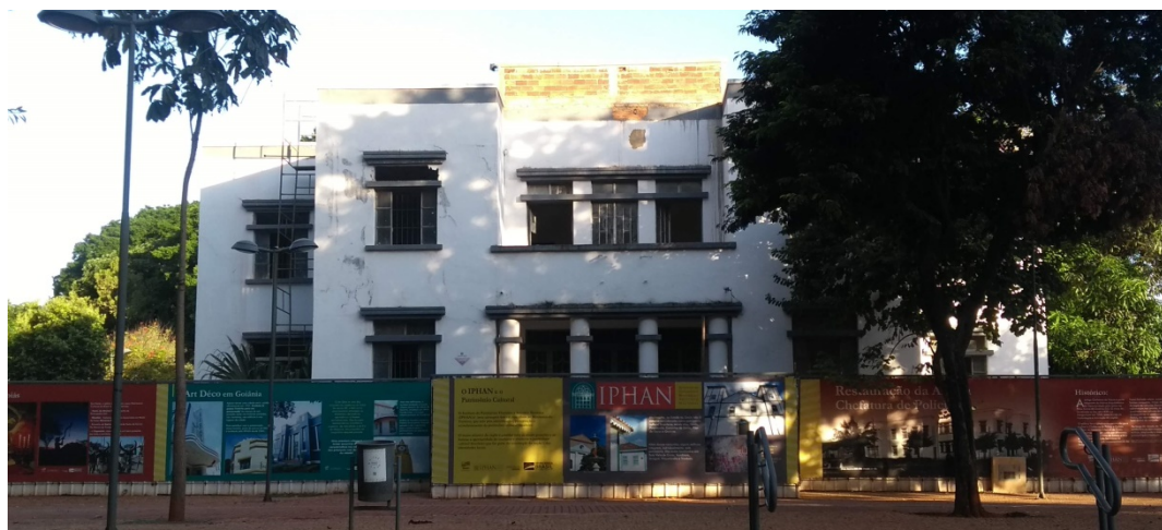
Figura 9: Obra em andamento de reforma da Antiga Chefatura de Polícia.
