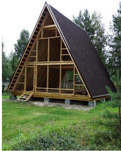
Figura 80. Casas pré-fabricadas de madera.
