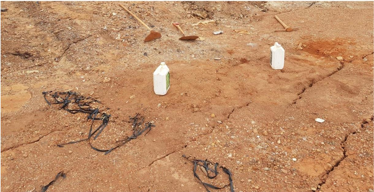
Figura 9 — Fissuras na cobertura do ACJC. Fonte: CUNHA, L. (2019)
