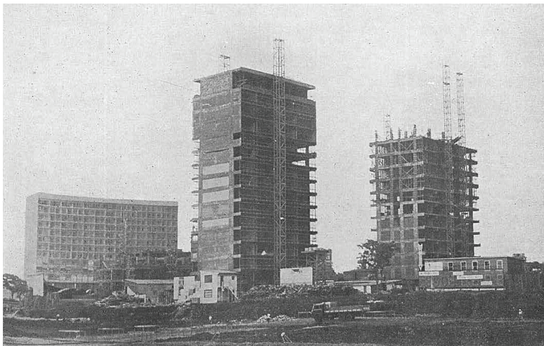
Figura 1.16: edifícios JK e ESOL em construção (com o edifício do Hospital de Base ao fundo) Fonte: Revista Brasília, nº 50-52, p. 19, 21 abr. de 1961.
