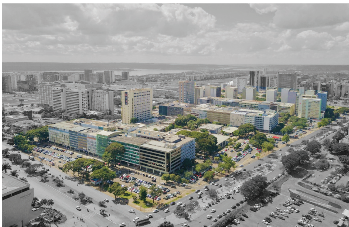
Figura 0.1: Foto aérea atual de parte da região central de Brasília, SCS em destaque (quadras 1 a 6) Fonte: Foto da autora
