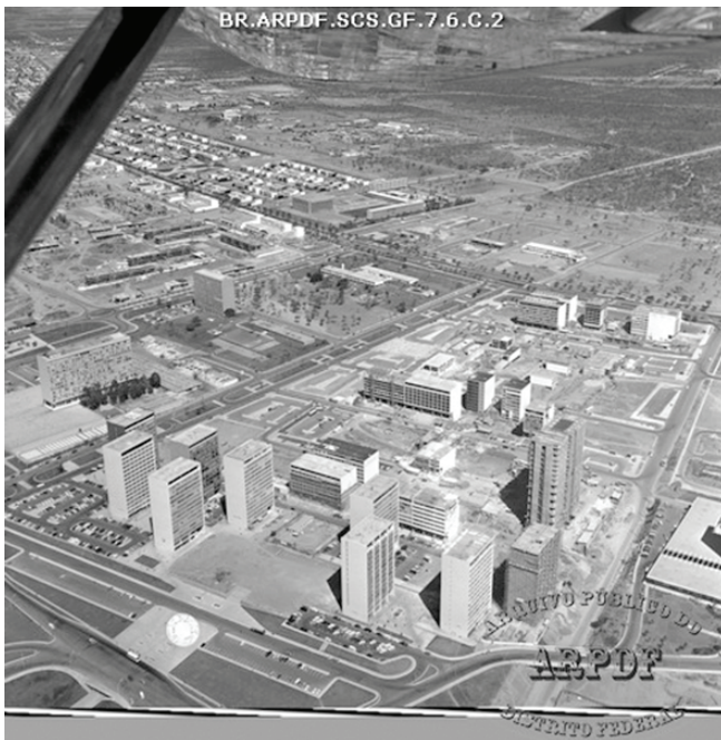
Figura 1.19: Situação construtiva de cada quadra, mesmo padrão dos CE, dez. 1968 Fonte: ArPDF (003007_SCS_GF_7_6_C_2)
