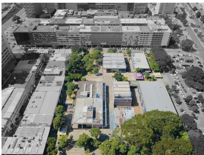
Figura 1.40: Foto aérea da Quadra 5, em que se percebe que algumas lajes e marquises não foram executadas
