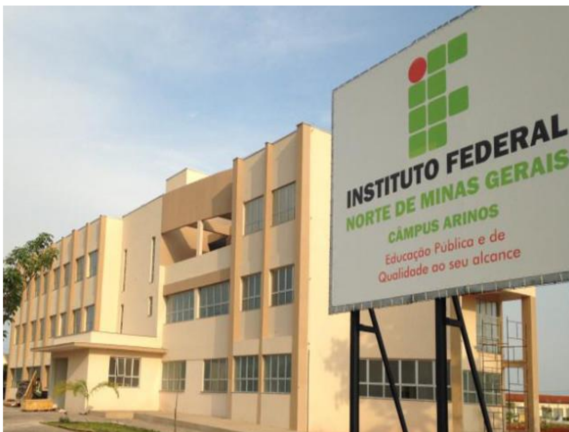
Figura 22 – Prédio do Centro de Desenvolvimento Tecnológico e Inovação (CDTI)
