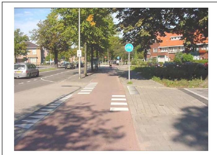
Figura 2. 14 - Exemplo de ciclovia separada da via adjacente.
