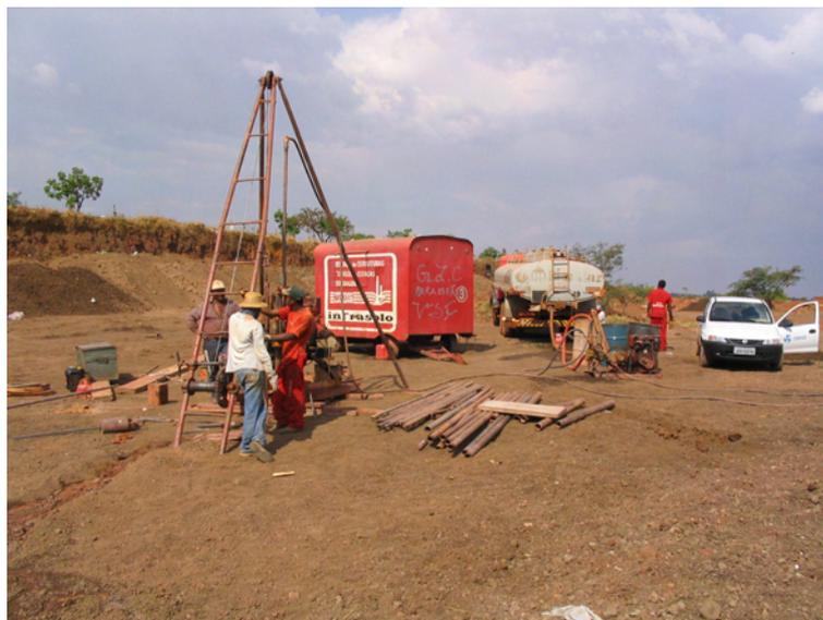
Figura 4.2 – Sondagem mista (rotativa e percussão) realizada na área de disposição do lodo da ETA-RD na cascalheira (Ponto S1).
