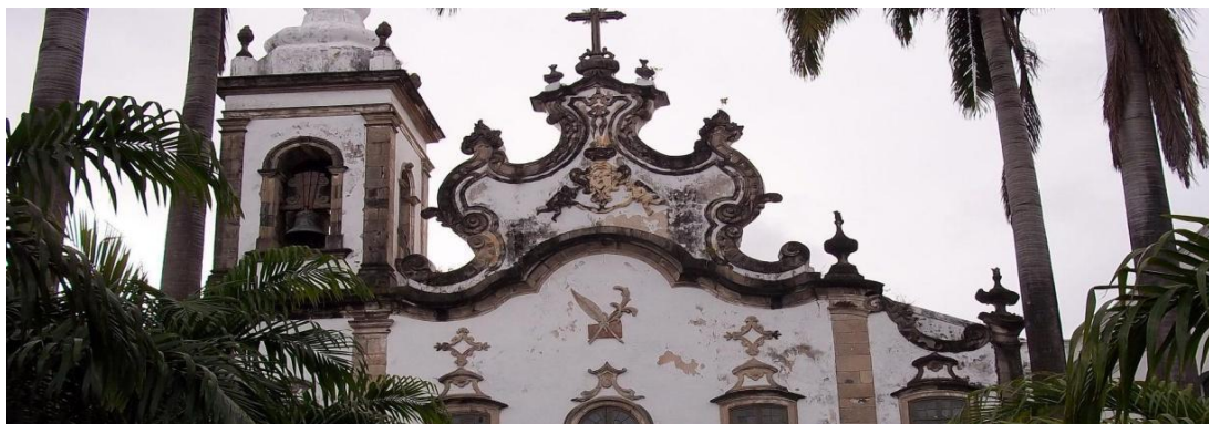
Fig. 4 - Torre Sineira da Igreja da Ordem Terceira de Nossa Senhora do Carmo, Recife, Pernambuco. Fonte: https://pinturasantateresa.wordpress.com/
