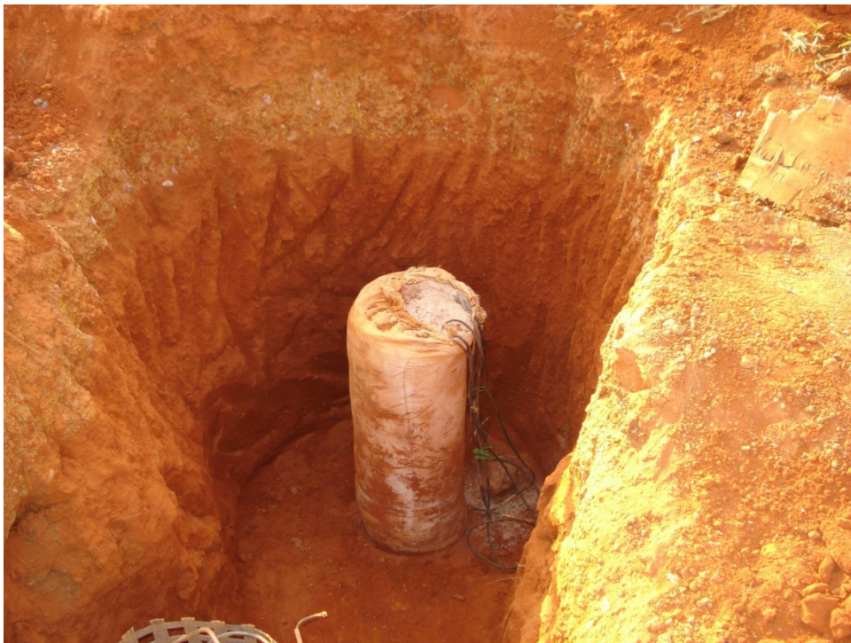
Figura 4.13. Exumação da coluna de areia encamisada.
