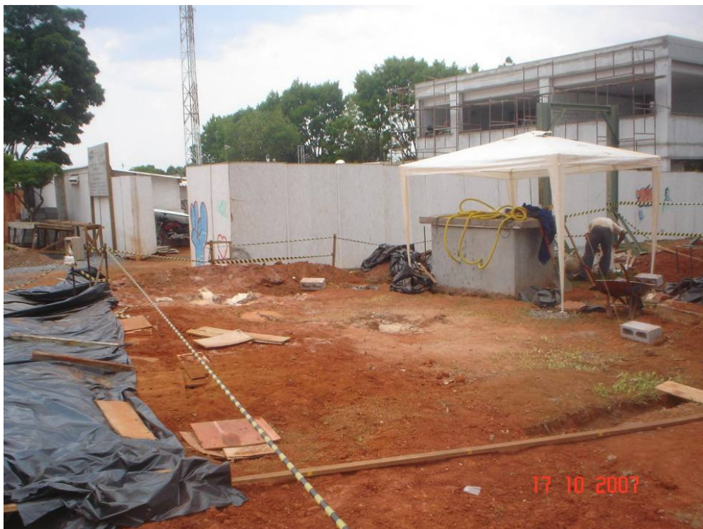
Figura 3.5. Local onde foram executadas as colunas.
