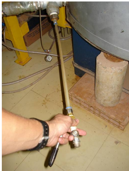
Figura 3.32. Mangueira utilizada para aplicação do vácuo na conexão por onde passa fiação.
