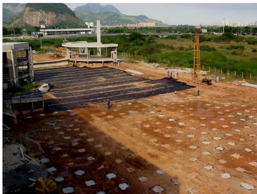
Figura 2.7. Vista geral do estaqueamento da obra do SESC/SENAC (Spotti, 2006).
