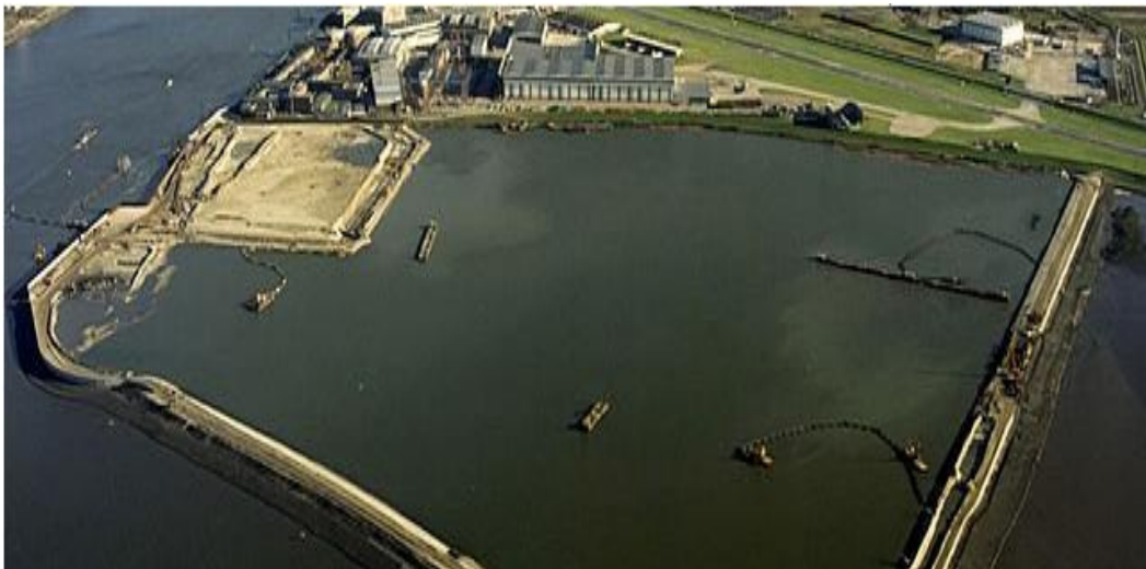
Figura 2.9. Vista panorâmica do dique em que foram utilizadas estacas granulares encamisadas com geotêxtil (Raithel et al. , 2002).
