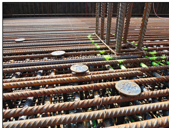
b) Double Headed Studs distribuídos radialmente (JORDAHL, 2017)
